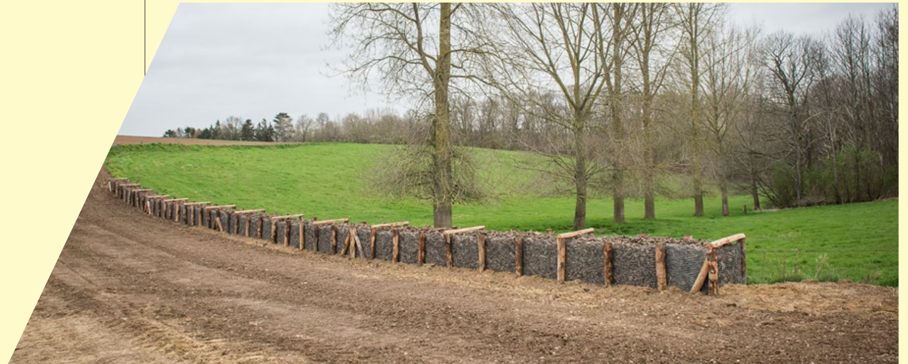
Houthakseldam in Huldenberg, aangelegd met VLIF-NPI en mogelijk gemaakt dankzij het project 'Samen erosie productief indammen'. © provincie Vlaams-Brabant.
