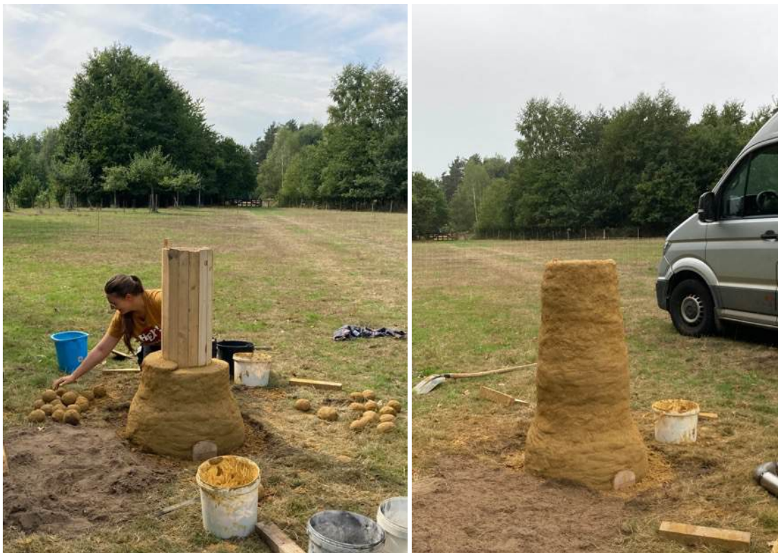
Fig. 7.1: De opbouw van de oven.
