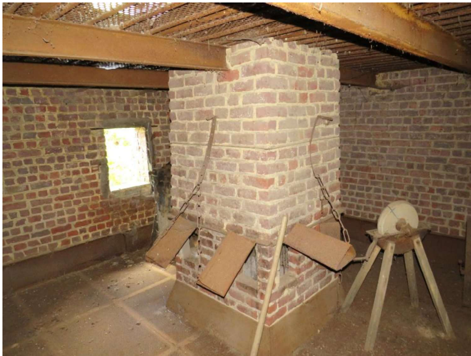
Fig. 50 – Onderste eestvloer in de cichoreiast Delezie in Anzegem (© 2024 Onroerend Erfgoed / Frank Becuwe).
