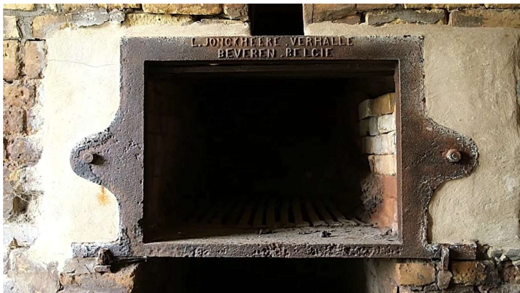
Fig. 245 – Gietijzeren cokesvuur, vervaardigd door constructeur L. Jonckheere-Verhalle, in de cichoreiast Vyaene in Lichtervelde (© Marc Cappelle).
