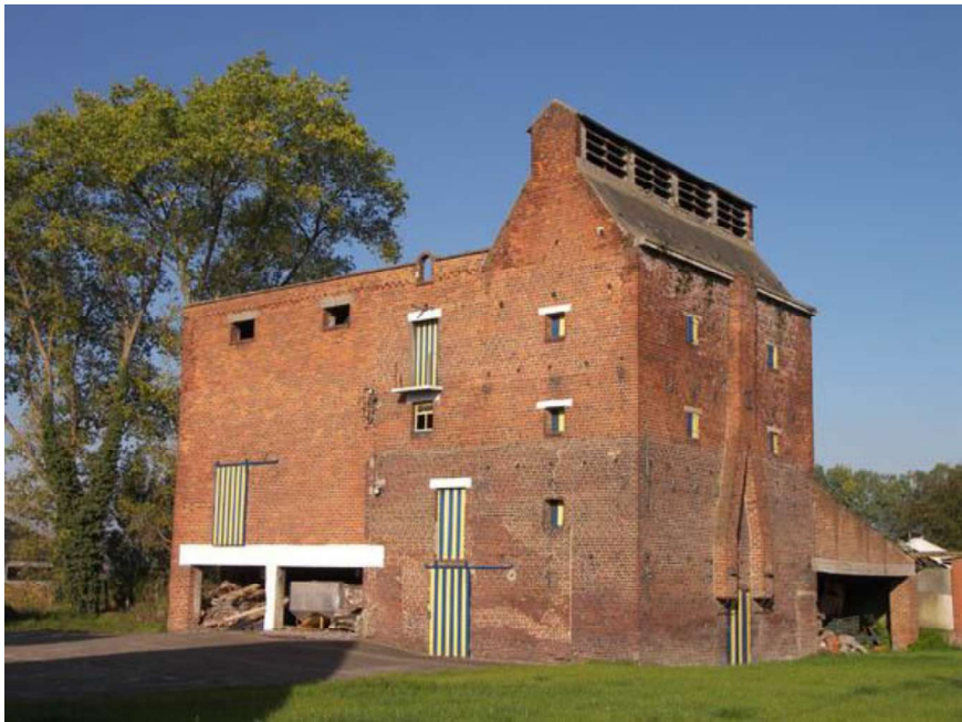
Fig. 190 – Cichoreiast op het Goed te Dierdonck in de Pittemstraat in Meulebeke (© 2007 Onroerend Erfgoed / Gonda Callaert).
