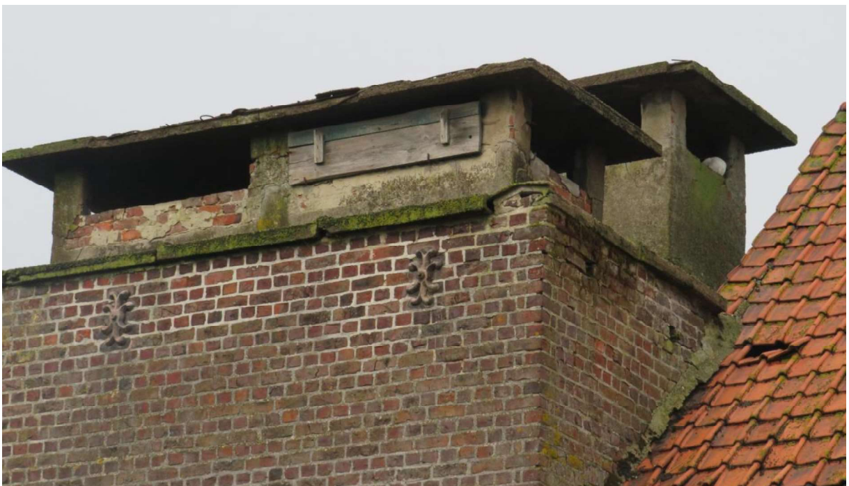
Fig. 172 – Detail van het plat dak van de cichoreiast in de Bollestraat in Gits (© 2024 Onroerend Erfgoed / Frank Becuwe).
