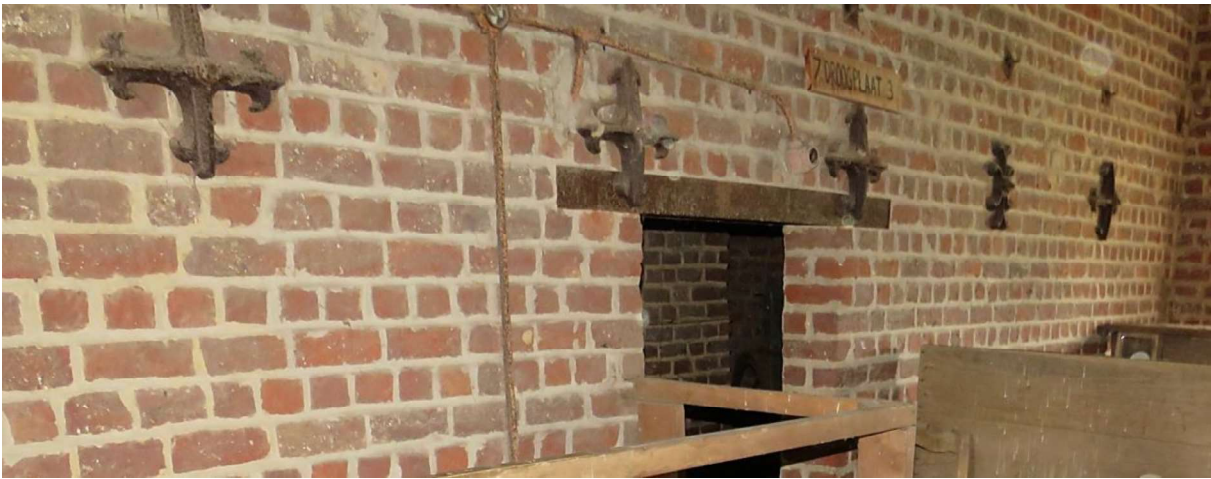
Fig. 147 – Sierlijke muurankers (interieur) van de cichoreiast Delezie in de Landergemweg in Anzegem (© 2024 Onroerend Erfgoed / Frank Becuwe).
