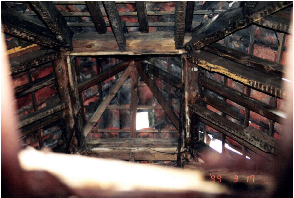
Fig. 143 – De dakconstructie van het tentdak van de inmiddels verdwenen cichoreiast in Ettenhoven in Hoevenen (© 1999 Onroerend Erfgoed / Annelies Van Craenenbroeck).
