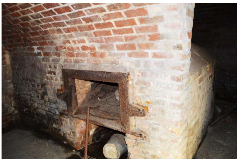
Fig. 59 (links) – Eén van de vier vuurhaarden in de cichoreiaast op de Heerlijkheid van Heule in Heule (© 2017 Frank Becuwe).
