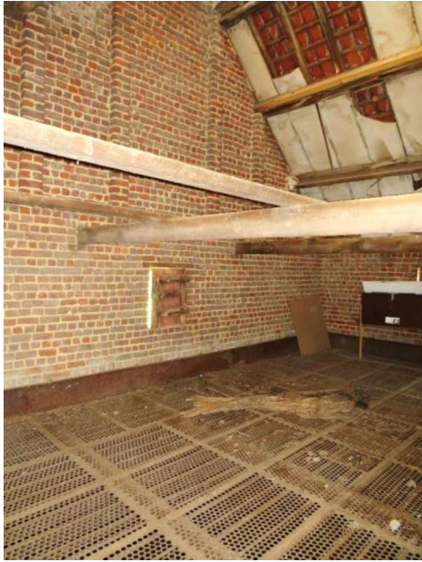
Fig. 48 (links) – Bovenste eestvloer in de cichoreiast Delezie in Anzegem (© 2024 Onroerend Erfgoed / Frank Becuwe). Fig. 49 (rechts) – Middelste eestvloer in de cichoreiast Delezie in Anzegem (© 2024 Onroerend Erfgoed / Frank Becuwe).
