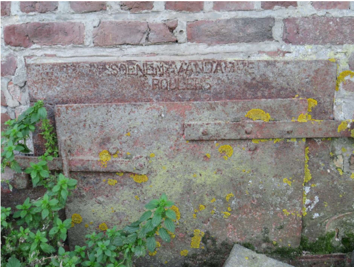
Fig. 244 – De oven met dubbele stookgaten in de cichoreiast van de Pollepelhoeve in Zillebeke. Op het metalen raamwerk van de stookgaten vermelding van de firma Soenen-Vandamme (© 2019 Onroerend Erfgoed / Frank Becuwe).
