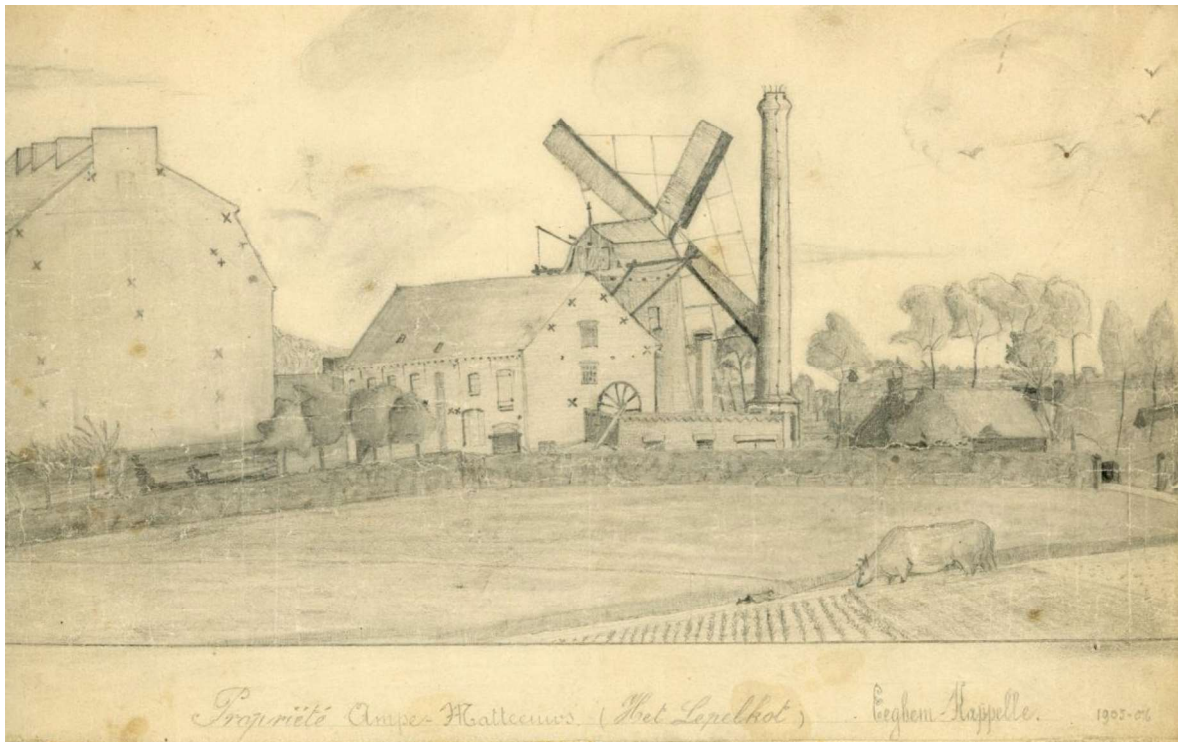
Fig. 194 – Tekening van het Egemse bedrijf Ampe-Mattheus omstreeks 1905 met links de cichoreiast en rechts de mechanische maalterij (met tegen de zijgevel een vliegwiel) (Collectie Bernard Lootens).
