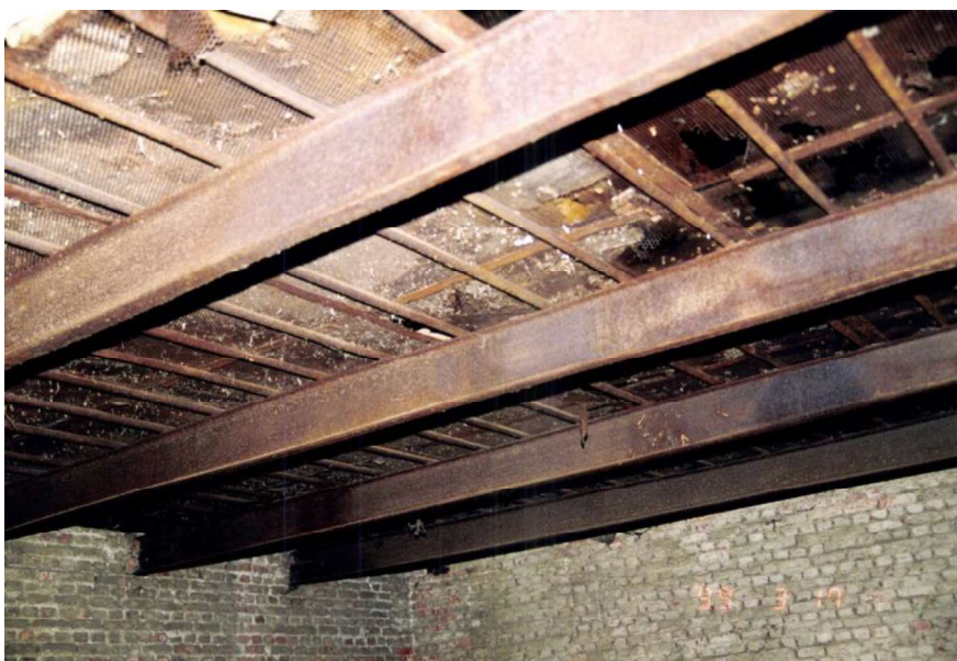
Fig. 155 – De metalen eestvloer in de voormalige cichoreiast in Ettenhoven 2 in Hoevenen (© 1999 Onroerend Erfgoed / Annelies Van Craenenbroeck).
