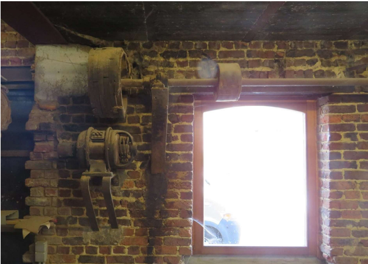
Fig. 238 – Elektromotor met transmissieas in de cichoreifabriek Eeman (© 2024 Onroerend erfgoed / Frank Becuwe).
