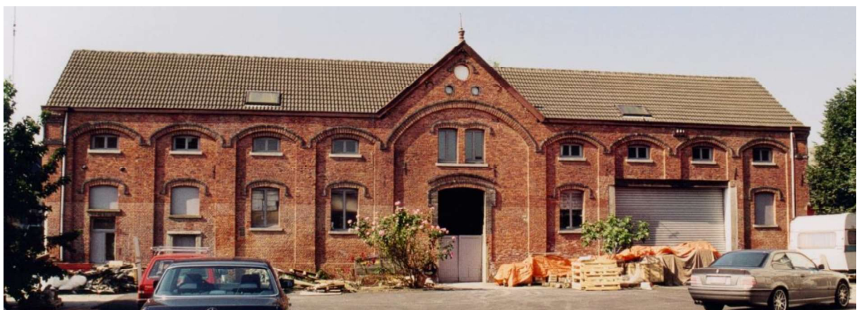
Fig. 213 – De voormalige cichoreifabriek Rayé in Vilvoorde (© 2007 Onroerend Erfgoed / Hilde Kennes).
