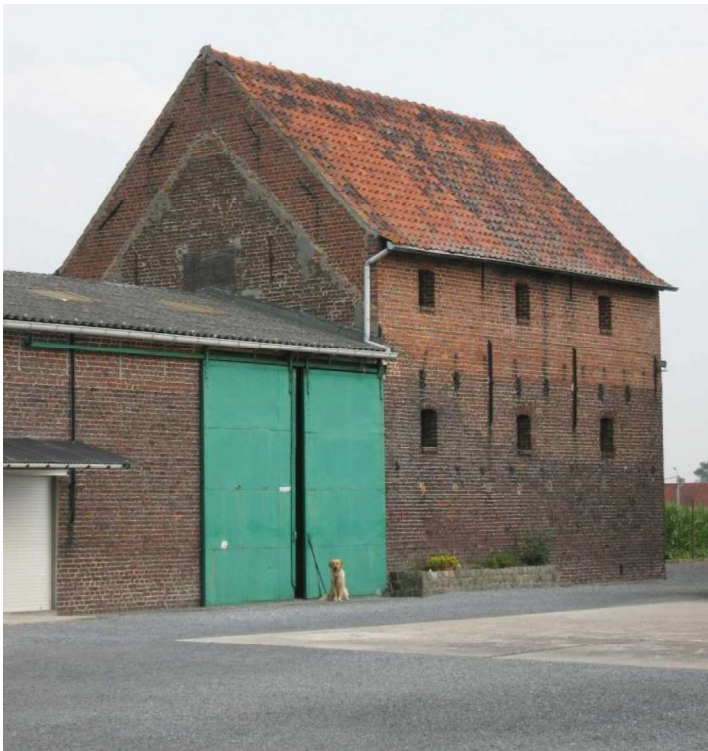
Fig. 158 – De met een verdieping verhoogde cichoreiast in de Wontergemstraat in Aarsele (© 2007 Onroerend Erfgoed / Gonda Callaert).
