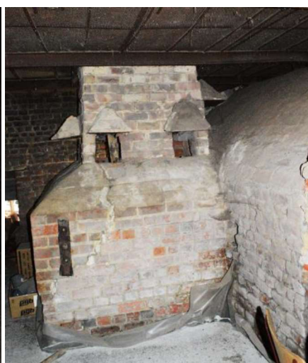
Fig. 59 (links) – Eén van de vier vuurhaarden in de cichoreiaast op de Heerlijkheid van Heule in Heule (© 2017 Frank Becuwe).
