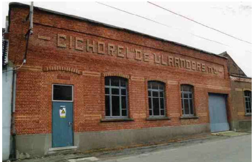
Fig. 212 – Eén van de bedrijfsgebouwen van de voormalige cichoreifabriek De Vlaanders in Oudegem (© 2001 Onroerend Erfgoed / Helena Duchêne).
