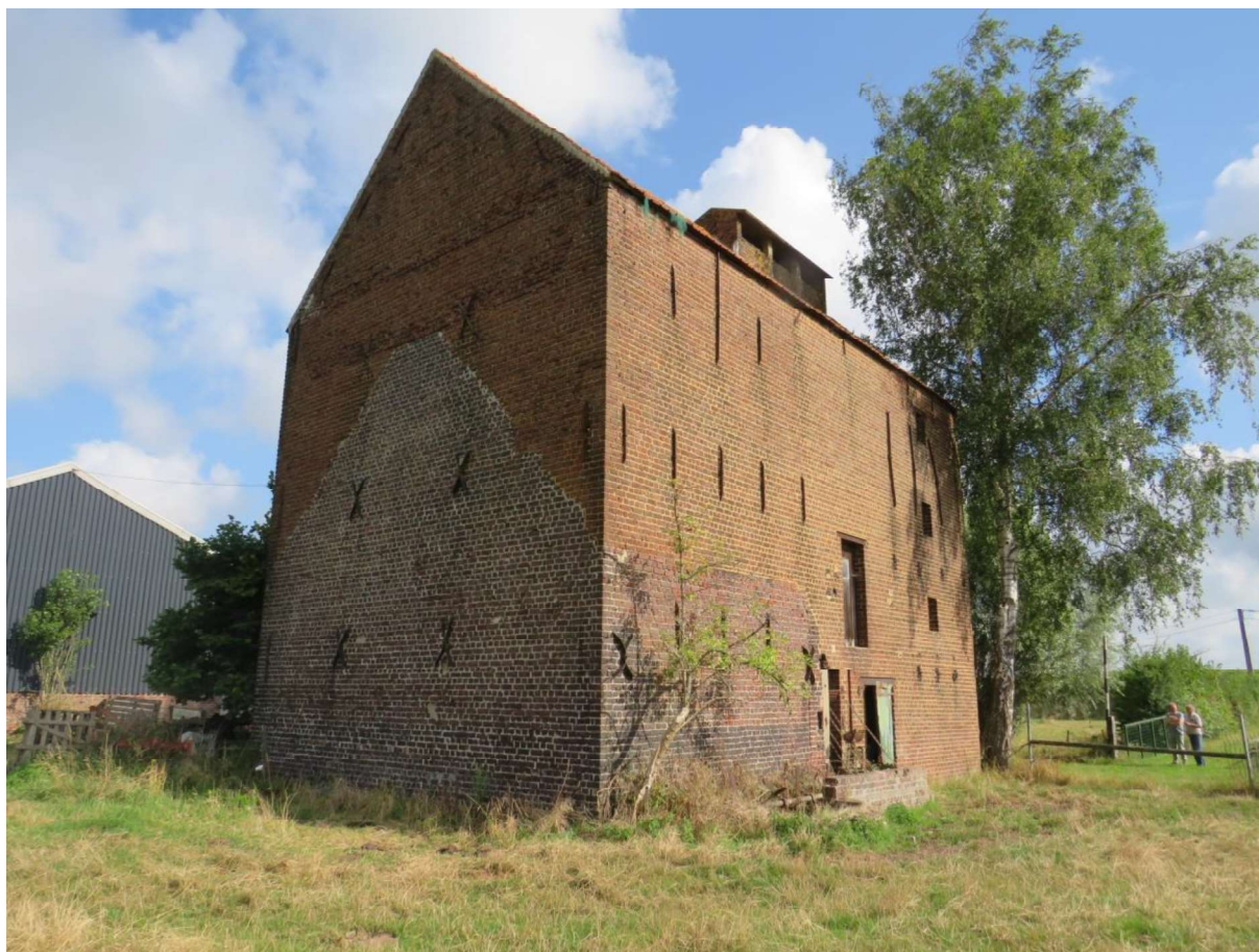
Fig. 131 – De in 1937 (herop)gebouwde cichoreiast Delezie in Anzegem. Let op de bouwsporen van de kleinere oude ast (© 2024 Onroerend Erfgoed / Frank Becuwe).
