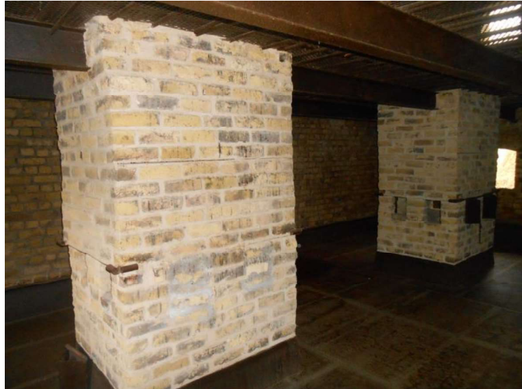
Fig. 176 (links) – Een van de twee met een metalen hoed afgedekte eestovenschouwen in de cichoreiast Delezie in Anzegem (© 2024 Onroerend Erfgoed / Frank Becuwe).
