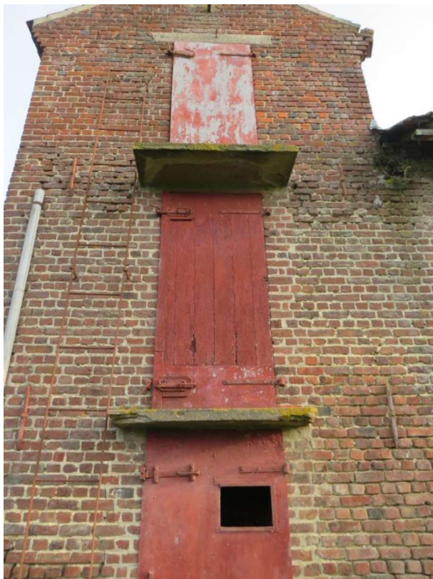
Fig. 148 – Betonnen luifels boven de laaddeuren van de cichoreiast op de Pollepelhoeve in Zillebeke (© 2019 Onroerend Erfgoed / Frank Becuwe).
