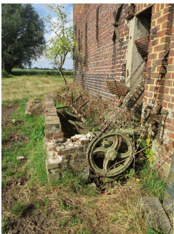
Fig. 33 – Waswaterbak met jacobsladder bij de cichoreiast Delezie in Anzegem (© 2024 Onroerend Erfgoed / Frank Becuwe).
