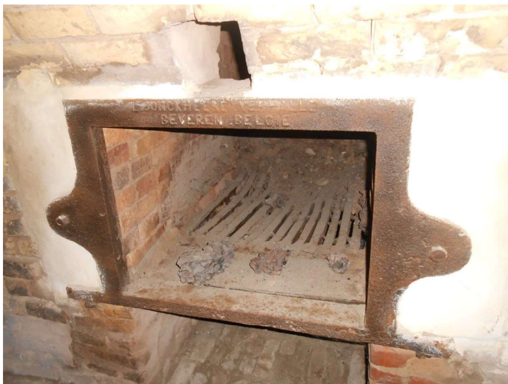
Fig. 246 – De door Jonckheere vervaardigde eestovens in de Sécherie Deleplace in het Noord-Franse Vieille-Eglise (© 2016 Frank Becuwe).
