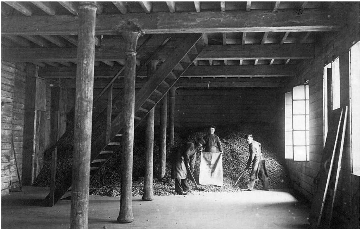
Fig. 77 – De droogzolder in de cichoreifabriek van Leopold De Ronne in Gent (Baillieul 2009).
