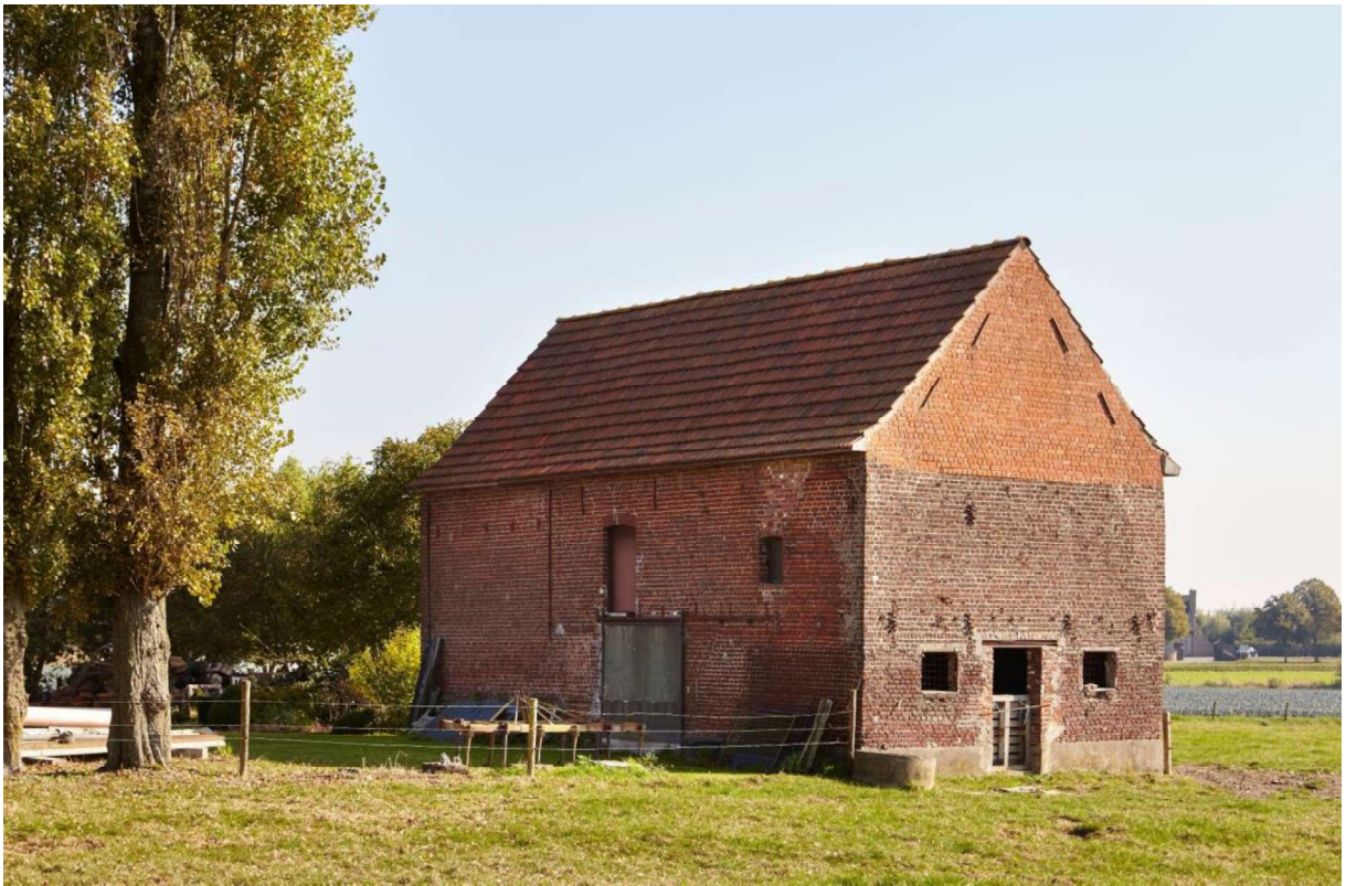
Fig. 138 – De tot stal verbouwde cichorei- en tabaksast in de Oude Heirweg in Moorslede (© 2016 Onroerend Erfgoed / Kris Vandevorst).
