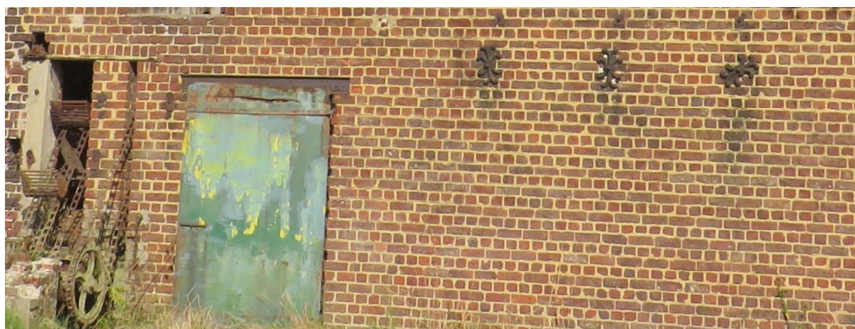
Fig. 146 – Sierlijke muurankers (exterieur) van de cichoreiast Delezie in de Landergemweg in Anzegem (© 2024 Onroerend Erfgoed / Frank Becuwe).
