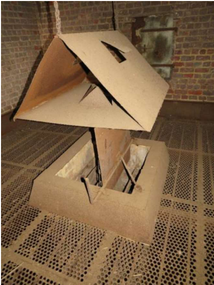
Fig. 176 (links) – Een van de twee met een metalen hoed afgedekte eestovenschouwen in de cichoreiast Delezie in Anzegem (© 2024 Onroerend Erfgoed / Frank Becuwe).
