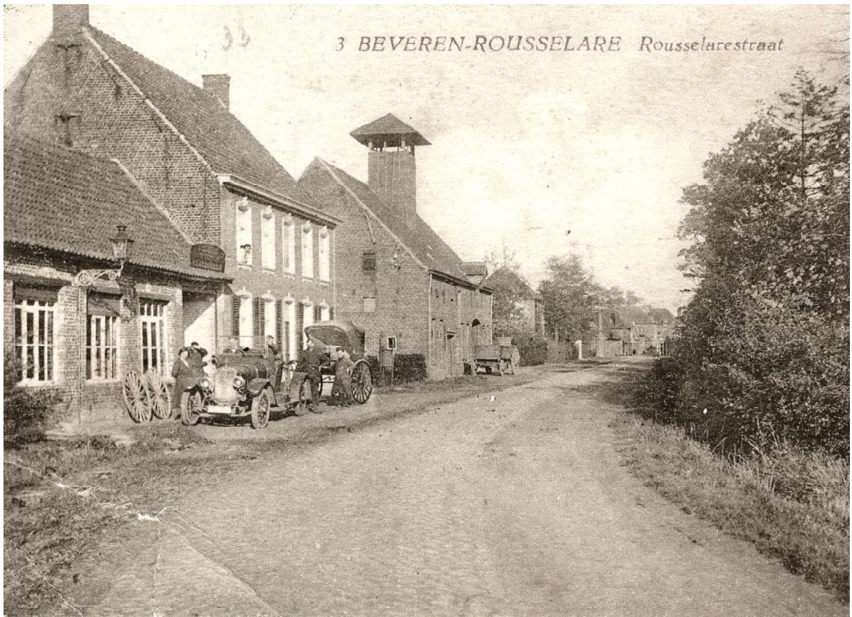
Fig. 151 – Cichoreiast van Alberic Eeckhout in Beveren (bij Roeselare). Let op de schoorsteen met vaste muts doorheen het zadeldak (Collectie Marc Cappelle).
