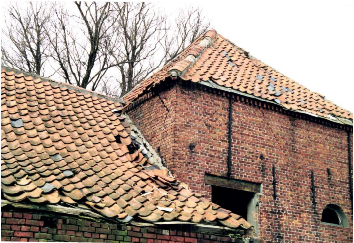
Fig. 142 – De inmiddels verdwenen cichoreiast onder pannen tentdak in Ettenhoven in Hoevenen (© 1999 Onroerend Erfgoed / Annelies Van Craenenbroeck).
