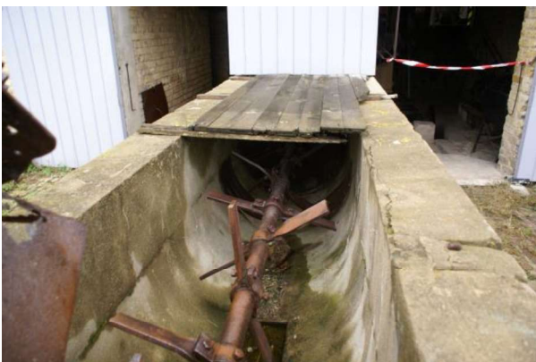
Fig. 39 (boven) – Betonnen spoelgracht met roteerinstallatie in de Sécherie Deleplace. Buiten opgesteld gedeelte (© 2016 Frank Becuwe).
