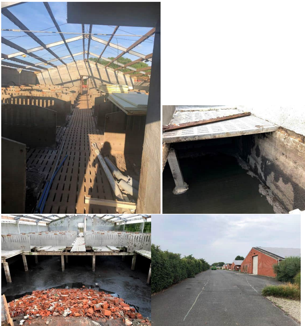
Foto 1 Foto's Houtmeerschen: Links boven: zicht op stal waarbij golfplaten reeds verwijderd werden maar structuren binnenin nog zichtbaar zijn. Links onder en Rechts boven: zich op opbouw met betonroosters en mestkelder. Rechtst onder; verharde zone met 4 achtereenvolgende stallen
