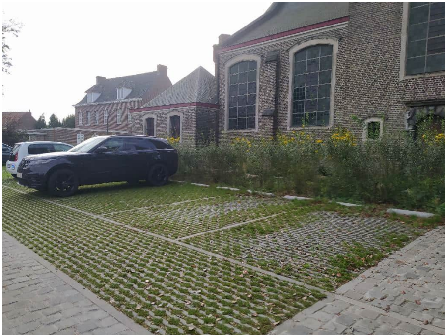
Foto 4: Parking in waterdoorlatende verharding aan de achterkant van de kerk
