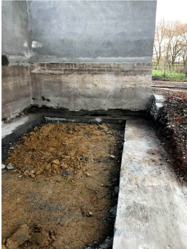
Foto 3 Foto Houtmeerschen : foto ondergrond onder vloerplaat
