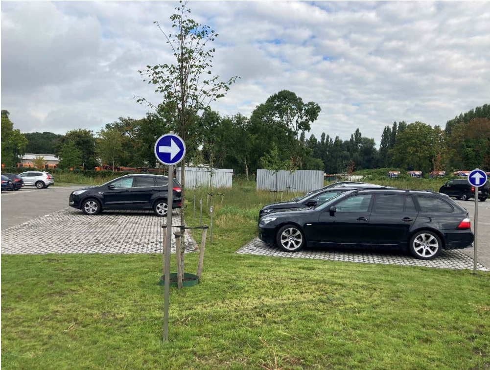
Foto 1 zicht op de parking met in het midden een infiltratiezone, aan weerszijden de semiverharde parkeerstroken en rijroute (lusvormig).
