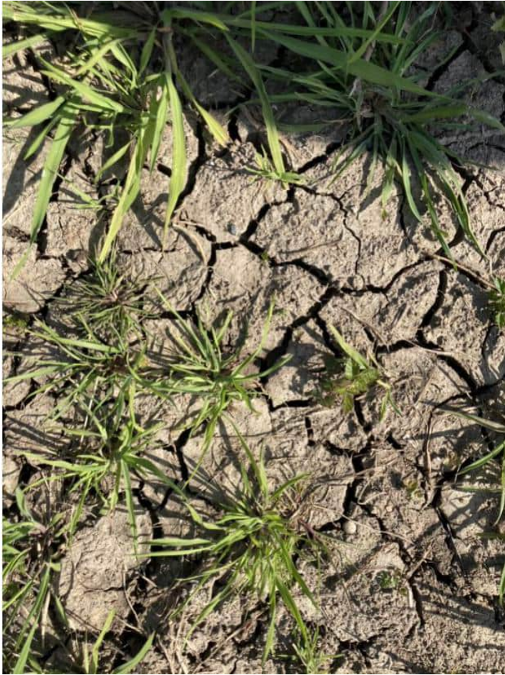
Foto 1 Detailfoto van onverharde zone (leembodem) met zichtbare barsten (droogte).
