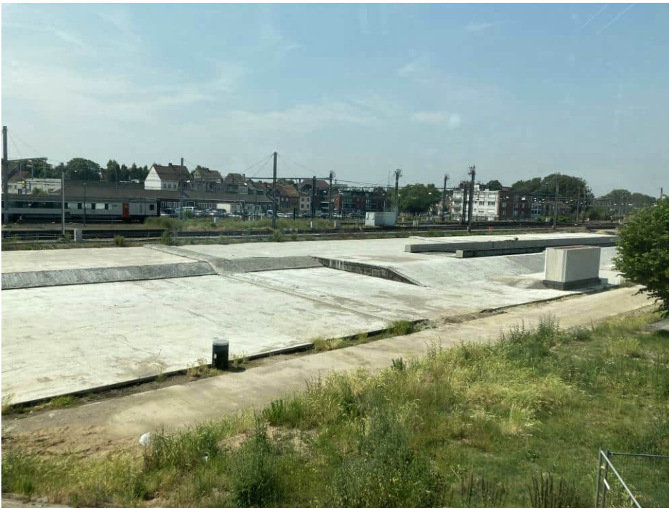
Foto 2: Nieuwe ondergrondse parking getrokken vanuit het 1ste verdieping van conservatoriumgebouw. Afwerking hiervan staat los van het onthardingsproject.
