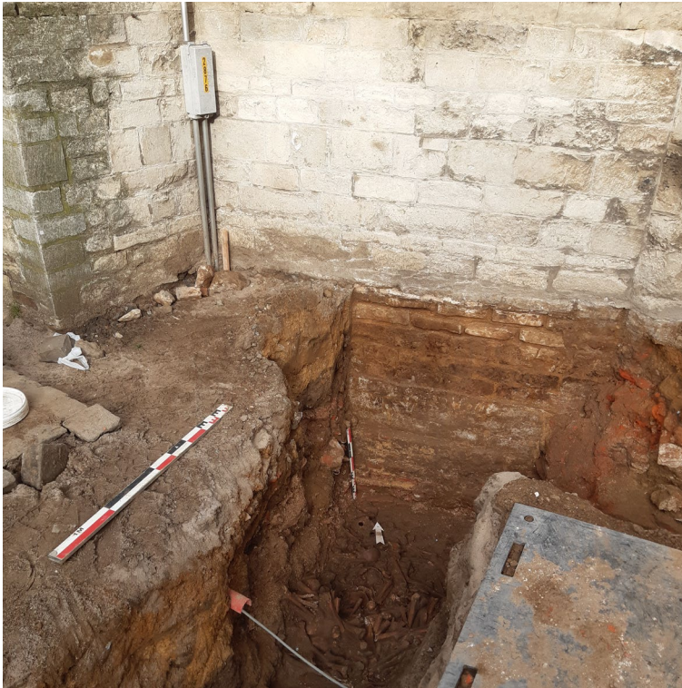
Figuur 16: Overzichtsfoto van de fundering en het opgaande muurwerk S1003 en S1005 (© agentschap Onroerend Erfgoed, foto: BAAC Vlaanderen).
