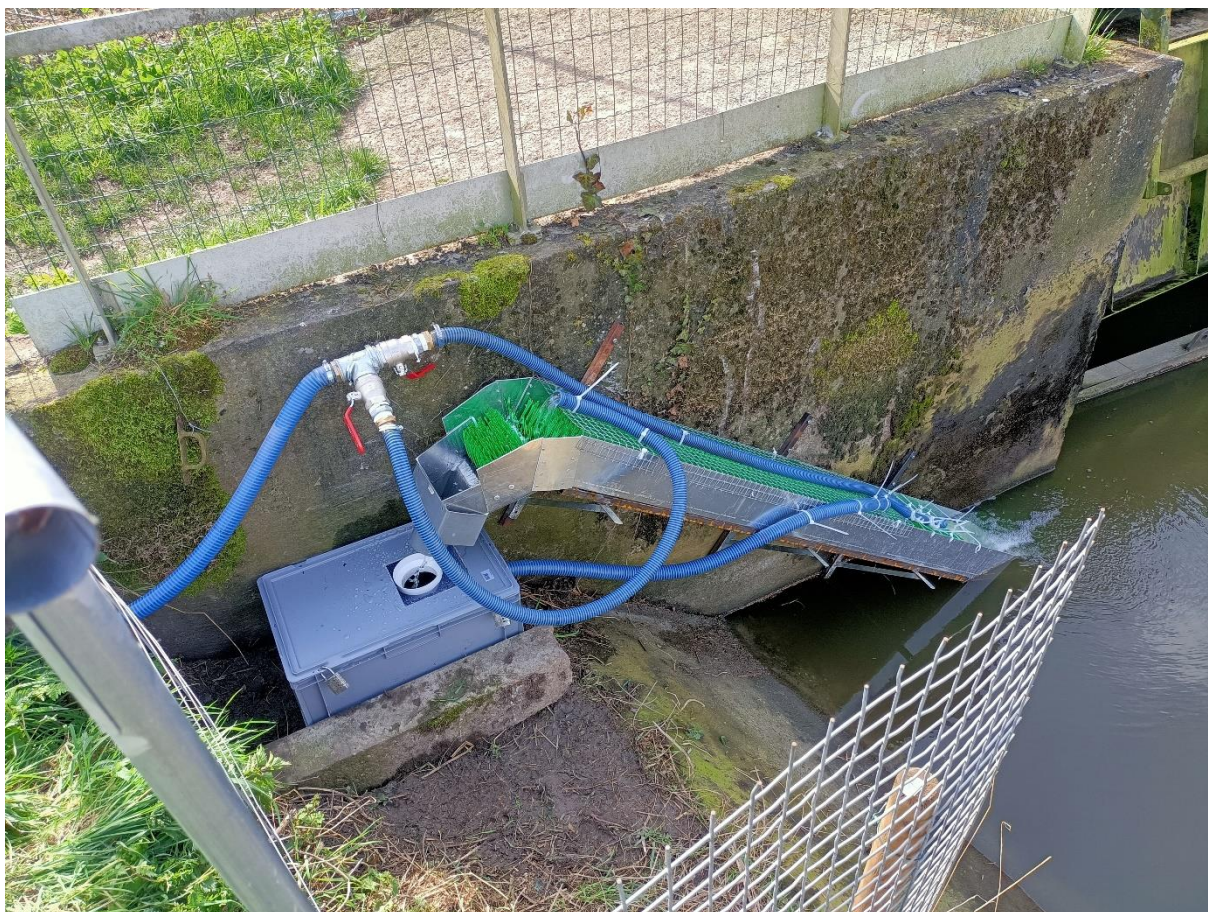
Figuur 4. De palinggoot aan het gemaal van Esen. Uit de blauwe darmen stroomt water vanuit de polder over de goot. De groene borstels vormen het substraat waarlangs jonge palingen omhoog kruipen om vervolgens in de grijze opvangbak terecht te komen.
