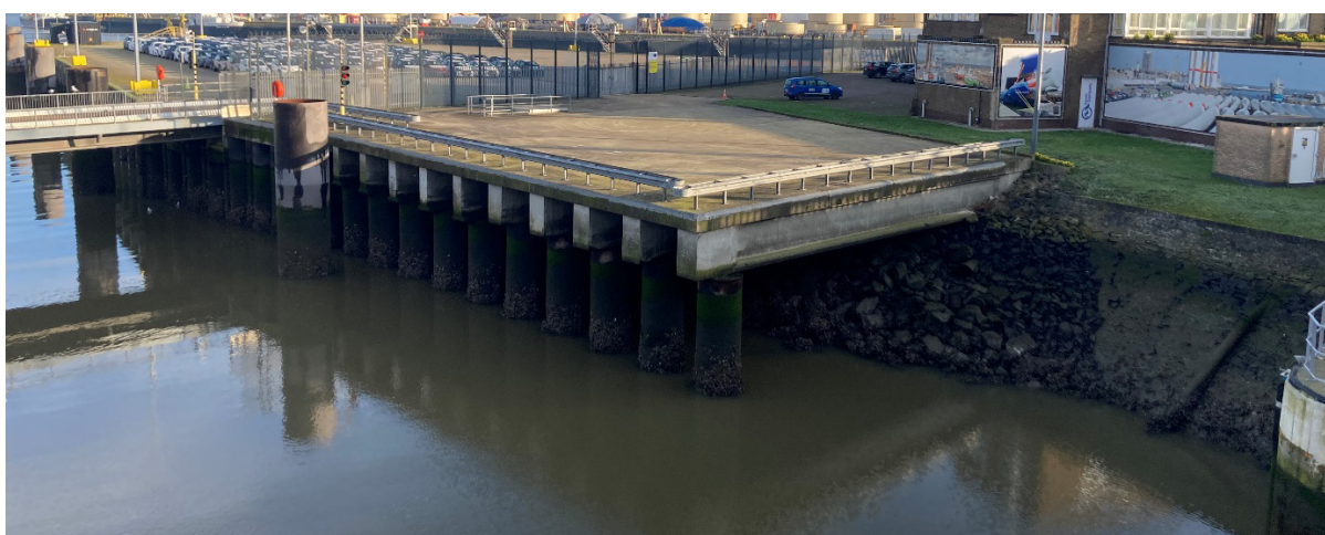
Figuur 5 – Zicht op oostelijke toegangsmuur Demeysluis van op de brug naast het zeevaartse sluis hoofd
