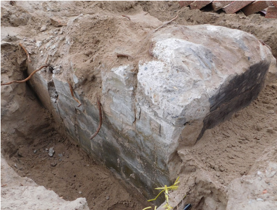
Figuur 27: Betonstructuur B, naar het noordwesten.
