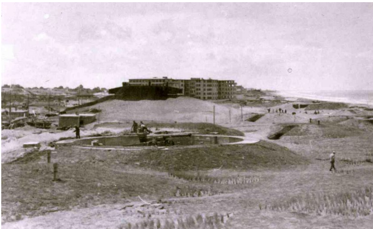
Figuur 17: Grondbeeld van kort na de oorlog, in de richting van het sanatorium (© KLM-MRA, via Pierre Nowak, uit: De Brant 2021, 70). Op de voorgrond is één van de zes geschutsofstellingen te zien, daarachter de grote vuurleidingsbunker.
