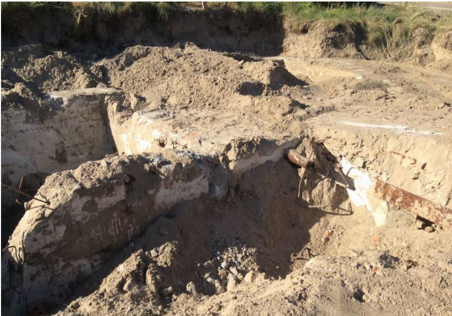
Figuur 38: Afbraak van een bunker in 2015, op de hoek van de Paardevisserweg met de Doornlaan. Foto via Pierre Nowak.
