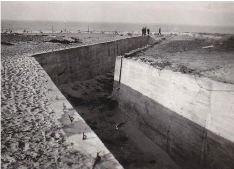
Figuur 32: Beeld van net na de oorlog van een antitankgracht met betonnen wanden, vermoedelijk in Knokke (Lefere et al. 2021, 134).
