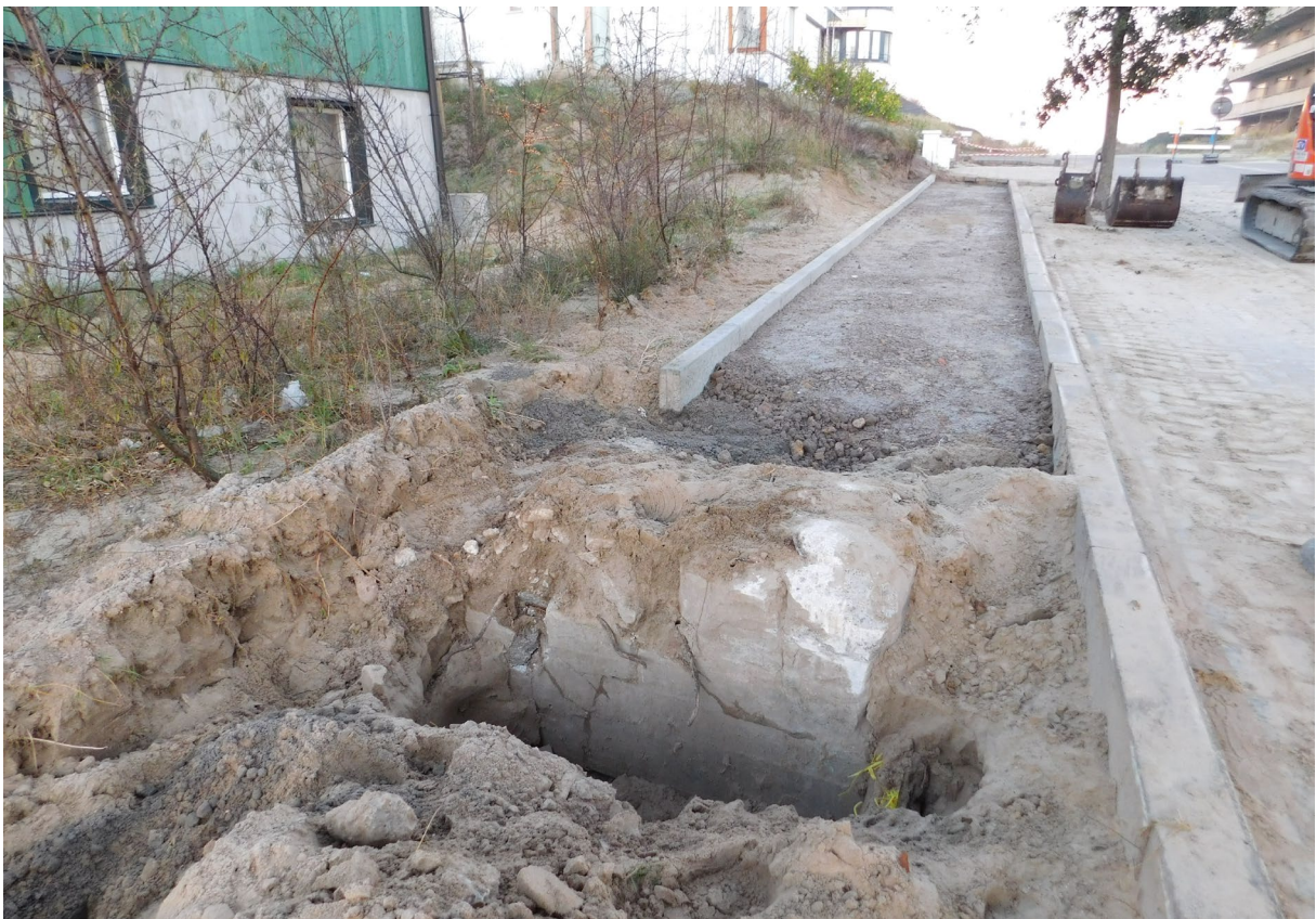
Figuur 25: TV ID 378, structuur B. Betonstructuur aangetroffen tijdens de wegeniswerken. Foto met zicht op omgeving, naar het noord/noordoosten.
