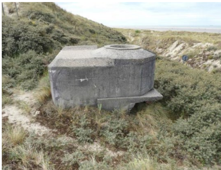
Figuur 34: Een bewaarde tobruk in (als monument beschermd) Widerstandsnest Waldersee , ten westen van het Sanatorium Groenendijk. Foto: Hannelore Decoodt.
