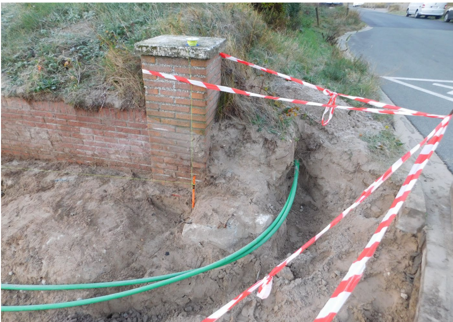
Figuur 28: TV ID 378, structuur A, net langs het uiteinde van de perceelsmuur. Foto naar het westen, de Dewittelaan in.
