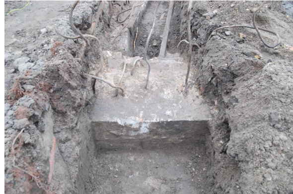
Figuur 17: Zicht op S5 vanuit het noordwesten. De afdrucken van de houten bekisting zijn nog duidelijk waar te nemen in het beton. © agentschap Onroerend Erfgoed.
