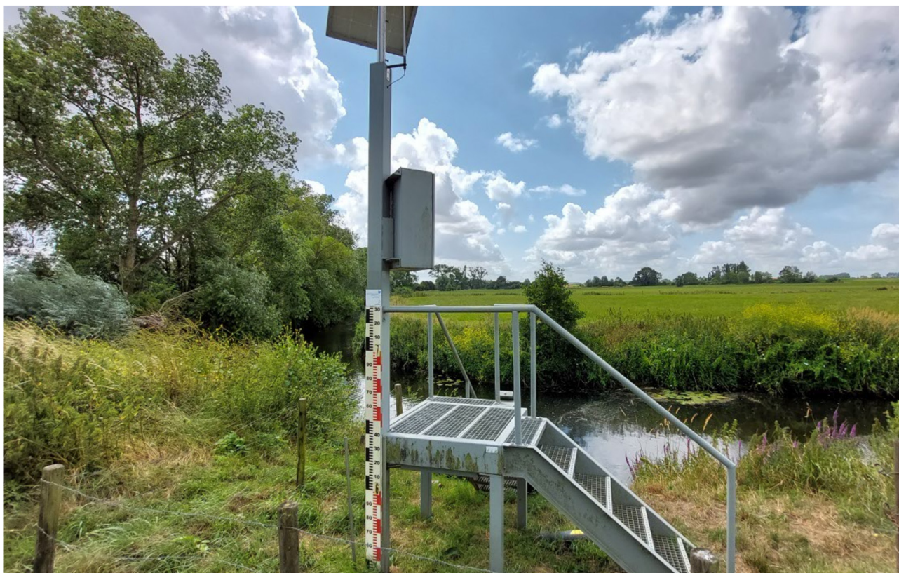
Figuur 2. Meetpost te Haringe op de IJzer op 2023-07-12, bij een peil van 3,08 mTAW. Debiet benadert 0 m 3 /s, maar moeilijk vast te stellen met een QH-verband.
