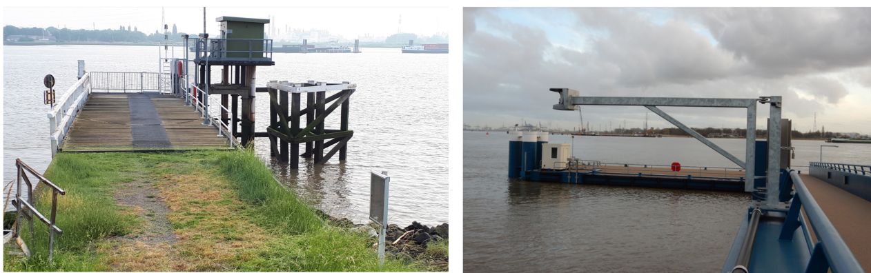
Figuur 22: Tijmeetlocatie te Liefkenshoek op de oude tijmeethut op dukdalf (links) en de huidige meetlocatie op het vast gedeelte van het veerpont (rechts) op de Beneden-Zeeschelde
