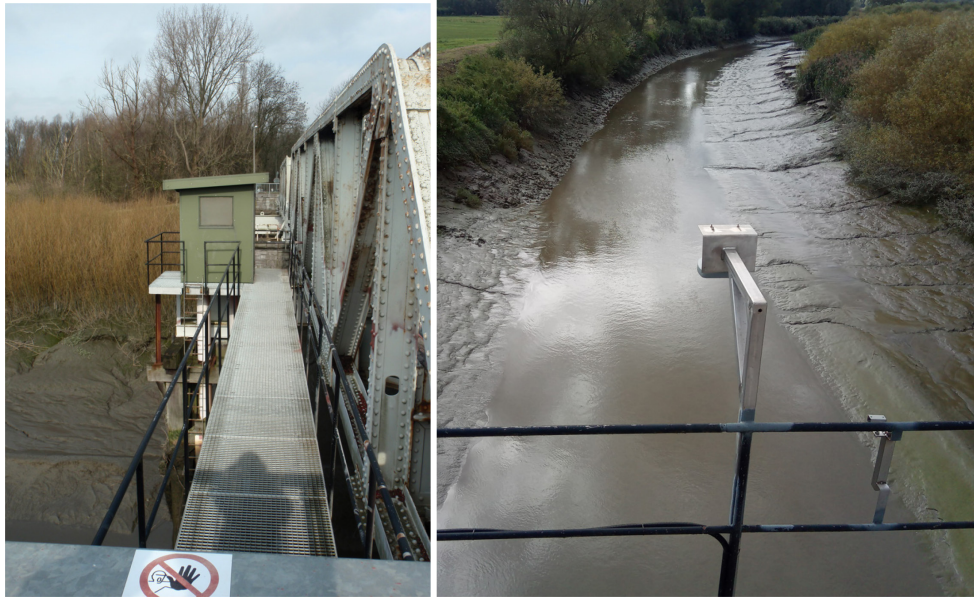
Figuur 67: Tijmeetopstelling te Waasmunster Brug op de Durme, met rechts zicht op de vrijstaande radar aan de brugleuning
