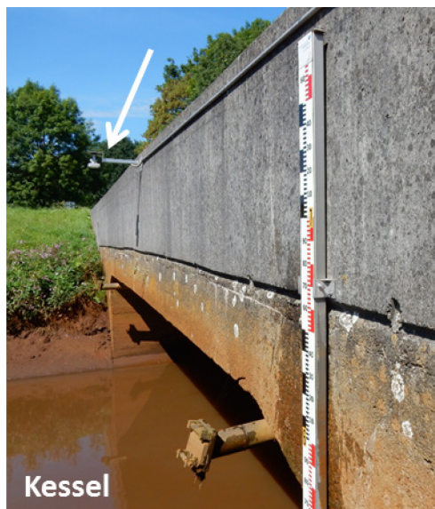
Figuur 3: Radararm bevestigd aan brug, getijpost Kessel
