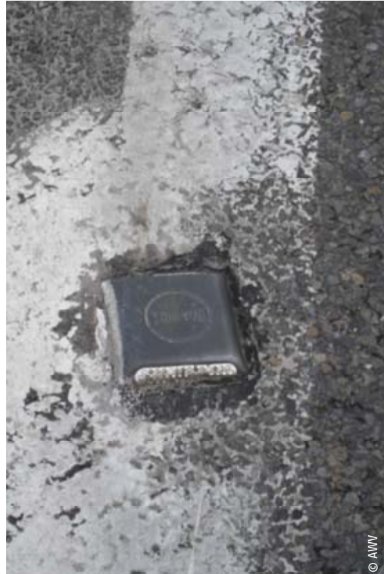
Foto: Wegdekreflectoren ter ondersteuning van het verrijingsvlak (Breendonk, Dendermondsesteenweg) – AWW
