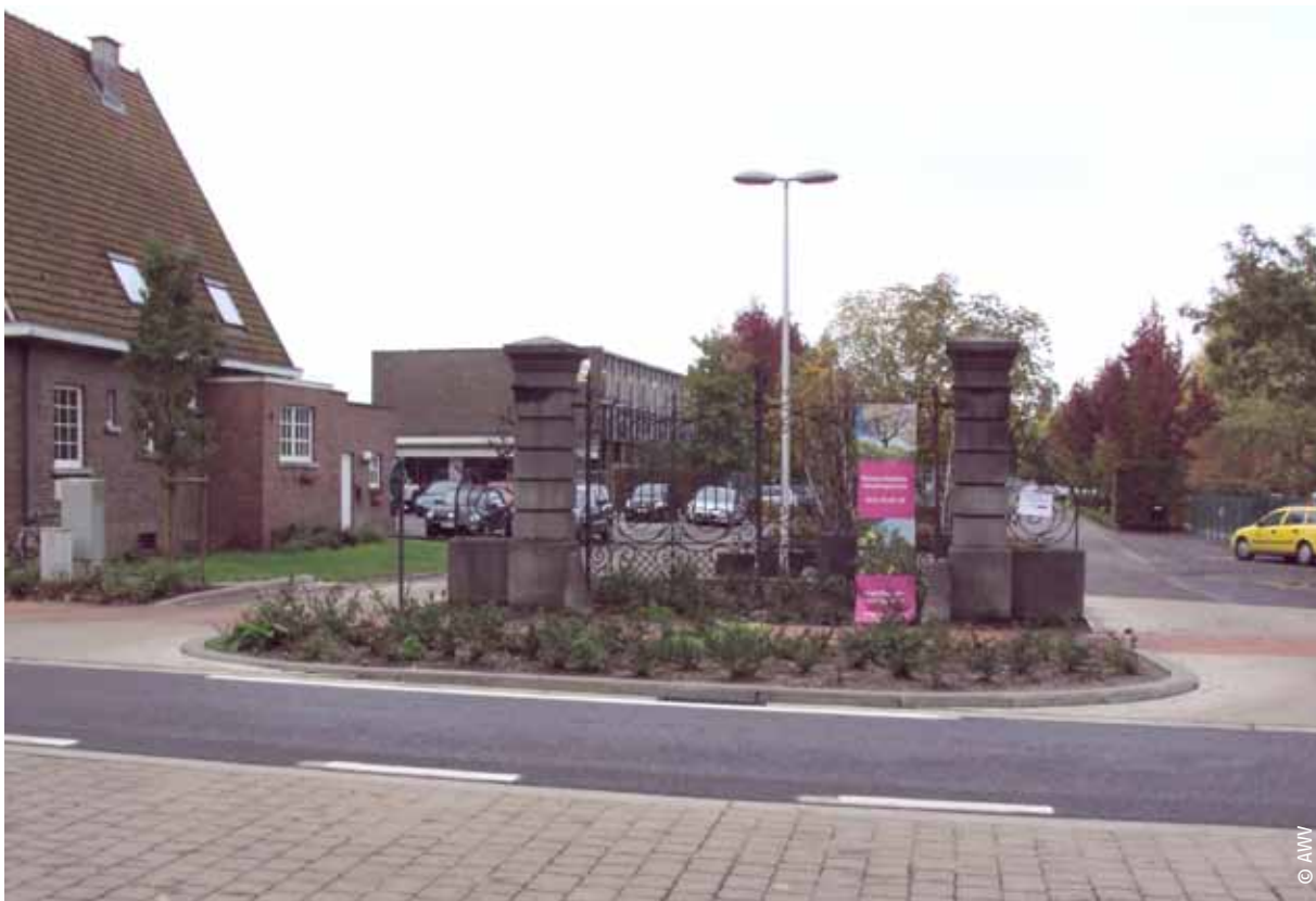
Foto: Aan deze school is de oude schoolpoort ingebed in een bloemenperkje, dat het inkomend en uitgaand verkeer van elkaar scheidt. Het perkje is doorgetrokken tot aan de weg om draaiende en kerende automanoeuvers vlak voor die vroegere schoolpoort te voorkomen
