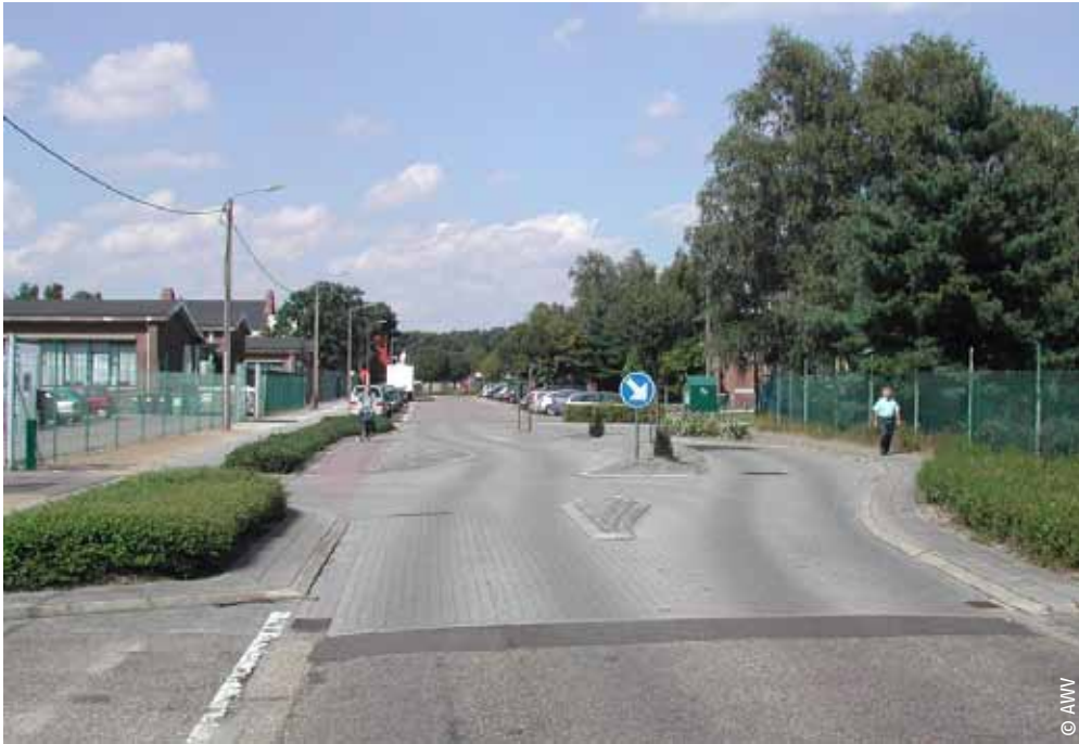
Foto: Een asverschuiving
