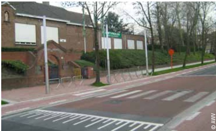
Foto: Kortrijk, Burgemeester F. de Bethunelaan. De kinderen kunnen dankzij de omegaprofielen niet rechtstreeks de straat oplopen. Naast de schooltoegang is een wachtruimte voorzien die eveneens afgeschermd is met omegaprofielen. De oversteek wordt ook beschermd door een verhoogde inrichting.
