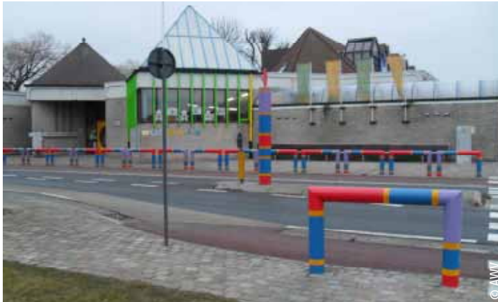
Foto: Oostduinkerke, Dorpstraat. Hier is er een oversteek in twee bewegingen, gecombineerd met een asverschuiving, aandachtstrekkers en natuurlijk de hekjes zelf.
