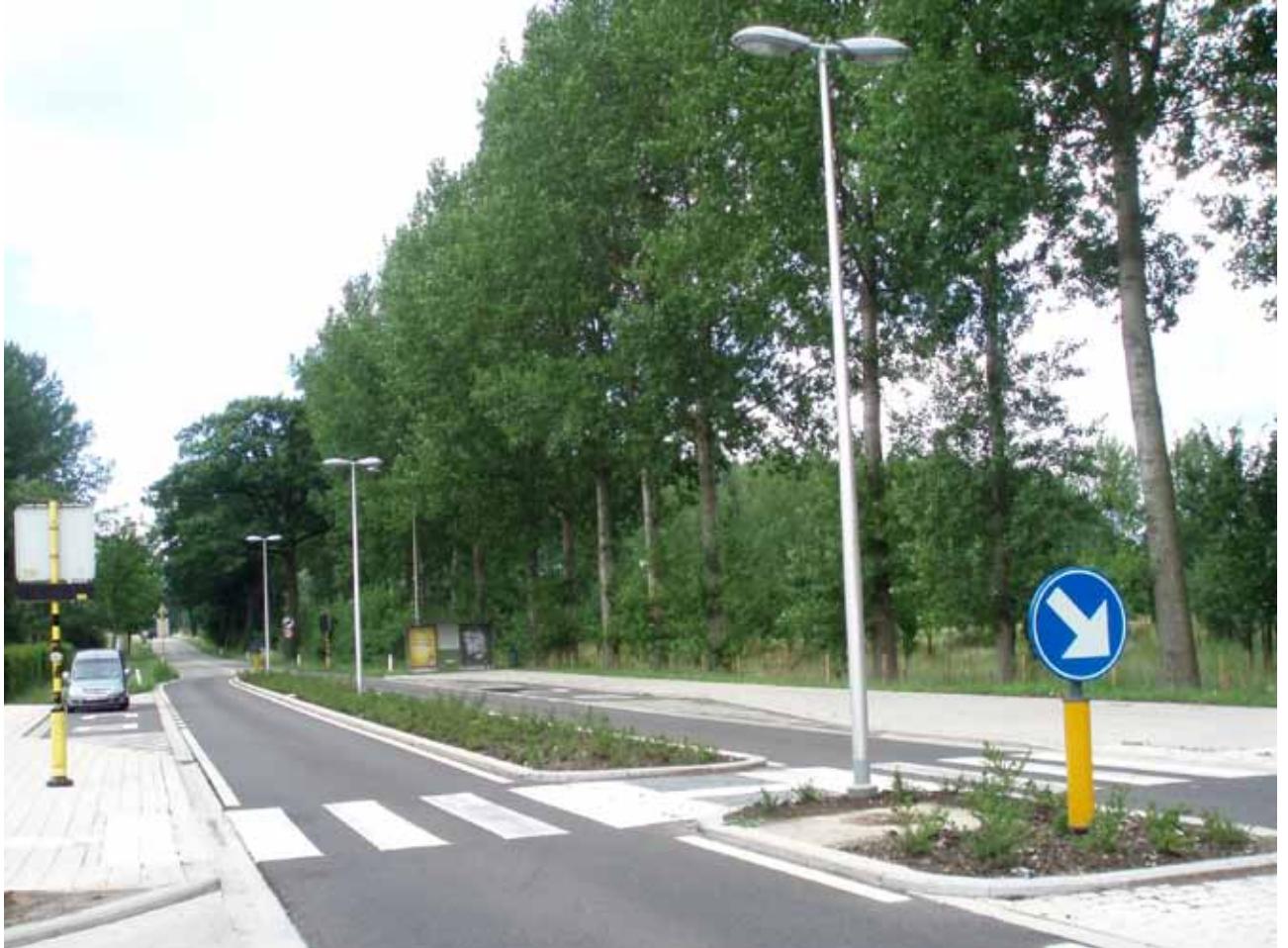
Foto: Door de aanleg van een middeneiland kan de oversteek hier in 2 keer gebeuren
