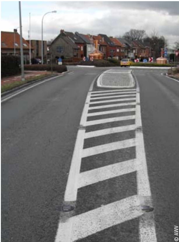
Foto: Wegdekreflectoren ter ondersteuning van het verrijingsvlak (Breendonk, Dendermondsesteenweg) – AWW
