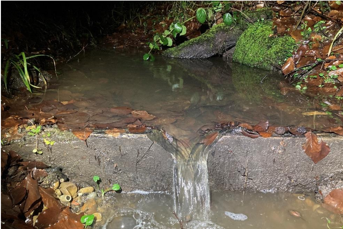
Figuur 92 Specifiek voor vuursalamander ontworpen houten stuw. De stuw wordt over de volledige breedte van de beek geplaatst. In het midden wordt een inkeping voorzien, waardoor erosie langs de zijkanten van de stuw wordt vermeden. Zowel boven als onder de stuw ontstaan geschikte plekken voor larven, waar water langer wordt vastgehouden en de stroomsnelheid afneemt. Zoniënwood, Brussel.
