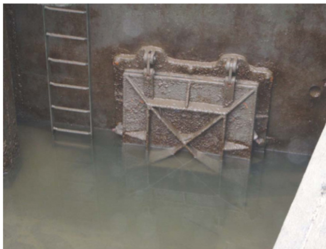
Figuur 2 – Voorbeeld gietijzeren terugslagklep (Environment Agency, s.d.)
