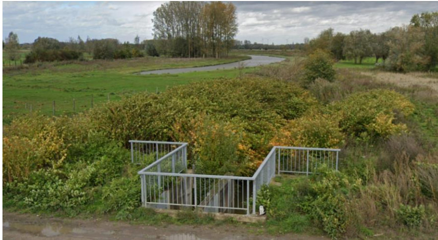
Foto 2: De Driesesloot is een relatief kleine watergang die via twee kokers afwatert in de Zeeschelde.
