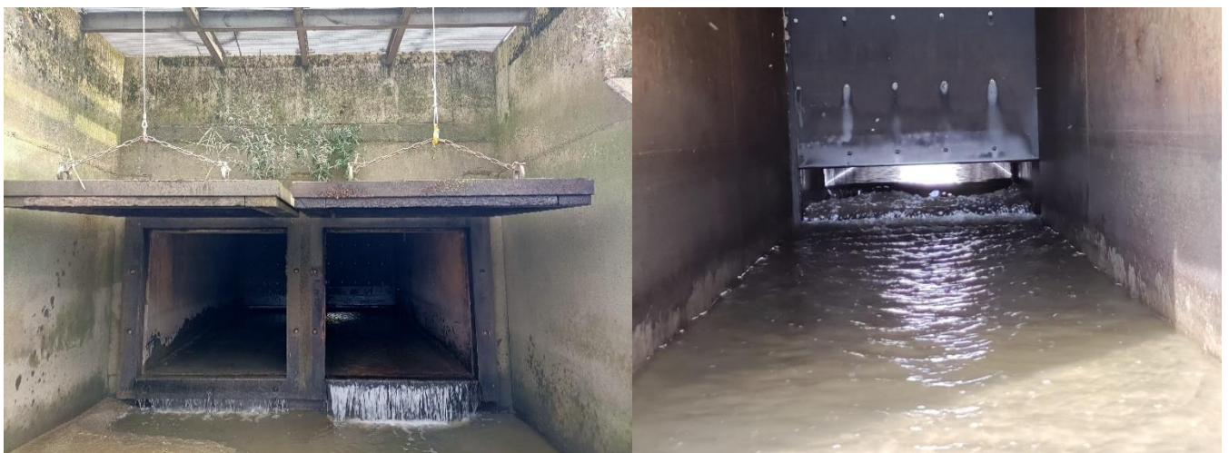
Foto 3: Links: De twee terugslagkleppen van de Driesesloot aan de zijde van de Zeeschelde. Door middel van een katrol werden deze manueel open gezet om het alternatief beheer (T1/T2) te testen. Rechts: de schuif in de uitwateringskoker die bij T0 volledig, T1 10cm en T2 20cm openstond.
