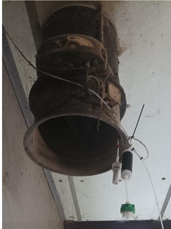
Figuur 22. Concentratiemetingen en bepaling van de adsorptiecapaciteit van Zeo A met behulp van een filterbox (wit-groene doos) in een vleesvarkensafdeling.
