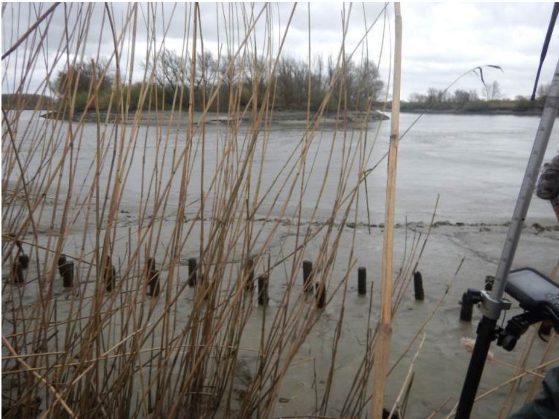
Figuur 13.35: NTMB-oever (natuurtechnische milieubouw), verstevigd met palenrijen aan de Kramp.
