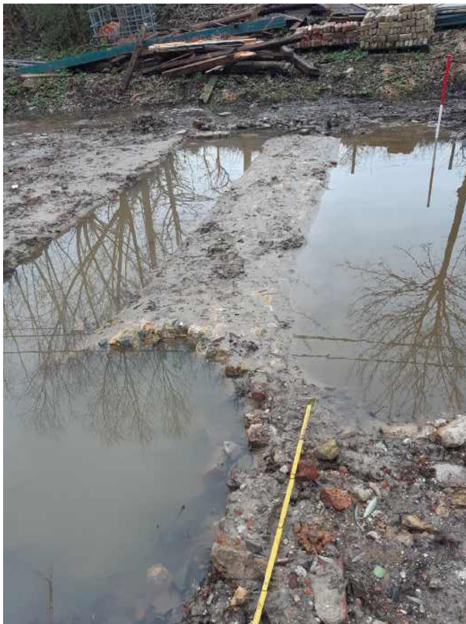
Figuur 1: Zicht op de bovenzijde van het tongewelf van de kelder (© agentschap Onroerend Erfgoed, foto: Sam De Decker).
