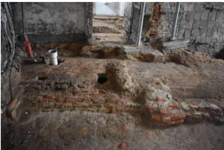
Tegen de noordzijde van de kelder is een smalle (één baksteen breed) muurfundering gemetst. Deze sluit aan de huidige binnenmuur aan en lijkt bedoeld om de haard van het huidige gebouw te ondersteunen.
