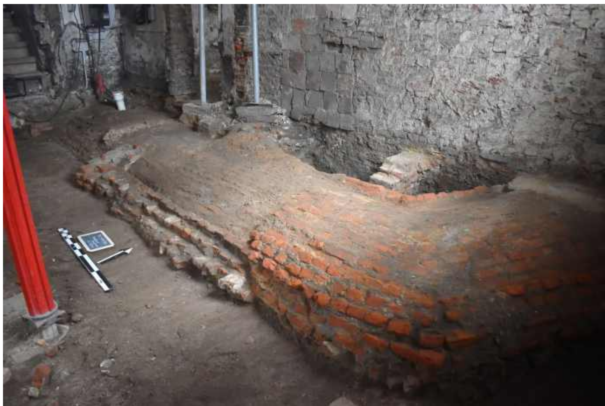
Figuur 4: Zicht op de bovenzijde van het keldergewelf in de zuidelijke kamer, gefotografeerd vanuit het zuidoosten (© agentschap Onroerend Erfgoed, foto: Marijn Van Gils).
