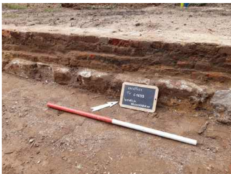
Figuur 2: Zicht op de fundering van de erfgevel, met gerecupereerde zandstenen blokken (© agentschap Onroerend Erfgoed, foto: Sam De Decker).
