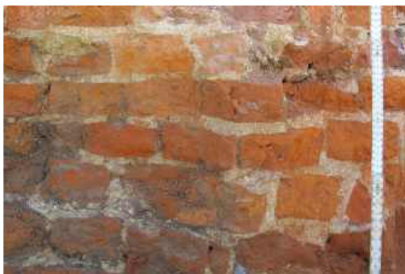
Figuur 3a en 3b: Detail van het de blauwe hardsteen in het baksteenmassief en detail van het metselverband (© agentschap Onroerend Erfgoed, foto: Peter Van Den Hove).
