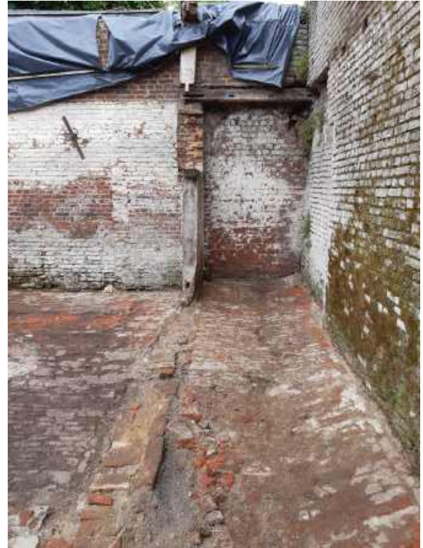
Figuur 4: Zicht op het westelijke gedeelte van de schuur, met dichtgemaakte deur in de zuidgevel en een bakstenen pad, en links daarvan een ruimte met bakstenen bevloering. Tegen de zuidgevel bevond zich een toilet met beerput (© agentschap Onroerend Erfgoed, foto Sam De Decker).
