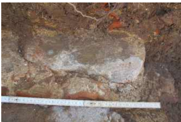
Figuur 3a en 3b: Detail van het de blauwe hardsteen in het baksteenmassief en detail van het metselverband (© agentschap Onroerend Erfgoed, foto: Peter Van Den Hove).
