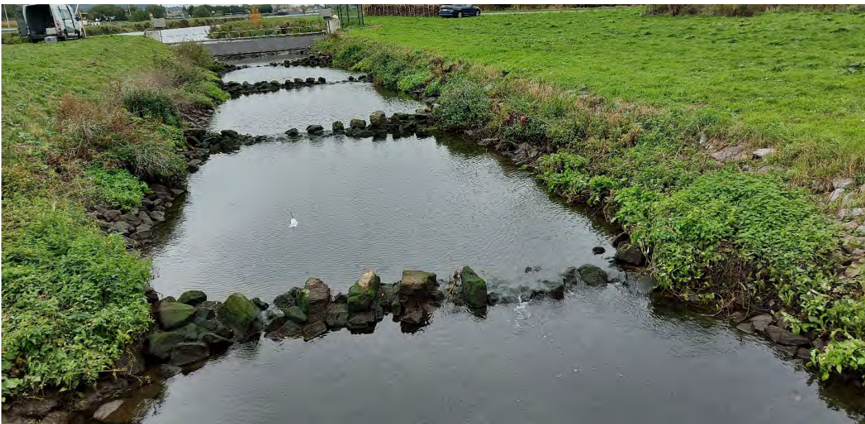
Figuur 3 – Zicht op drempel 1 tot en met 4 bij gesloten vispassage (05/10/2022).
