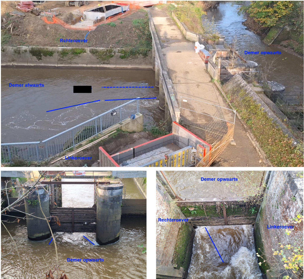
Figuur 12 – Stroming afwaarts van Grote Steunbeer bij laag debiet; zwart: indicatieve positie van de tijdelijke brugpijler; blauwe lijnen: Zone met hoge stroomsnelheid; blauwe streeplijnen: zone met lagere stroomsnelheid
