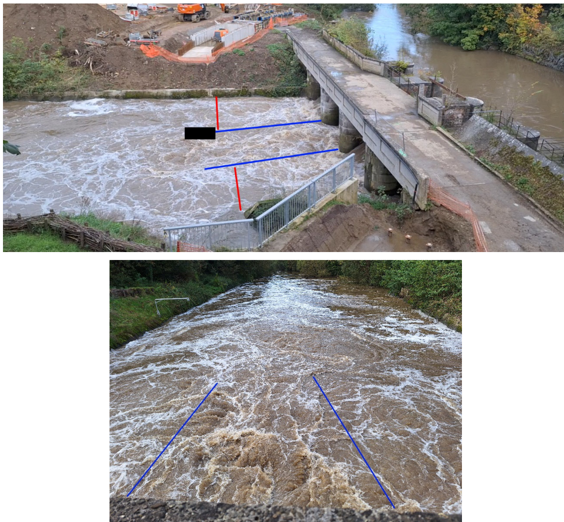
Figuur 11 – Stroming afwaarts van Grote Steunbeer op 10/10/2024; zwart: indicatieve positie van de tijdelijke brugpijler, rode lijnen: visueel bepaald einde van watersprong; blauwe lijnen: visueel bepaalde scheiding tussen stroming uit middenopening en stroming uit de zijopeningen
