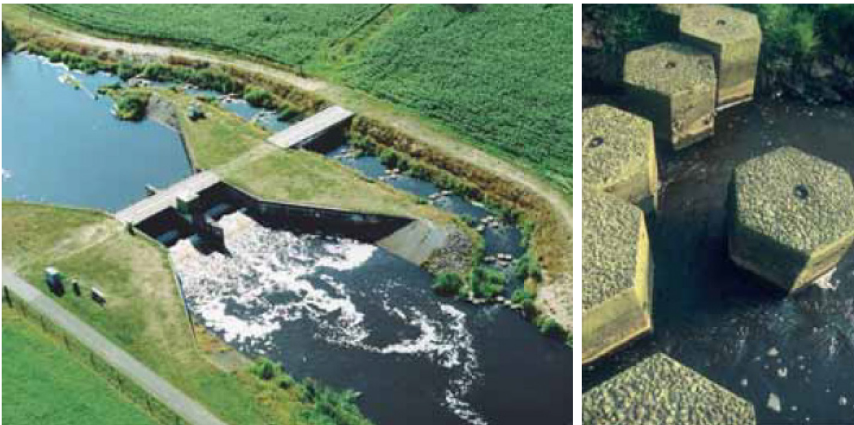
Figuur 21 – Voorbeeld op de Regge te Overwater (NL) van een vertical slot-vispassage geïntegreerd in een nevengeul. Links: overzicht ligging (Foto: Waterschap Regge en Dinkel) Rechts: Detailopname van een slot (Foto: OVB). Overgenomen uit AMINAL (2005)
