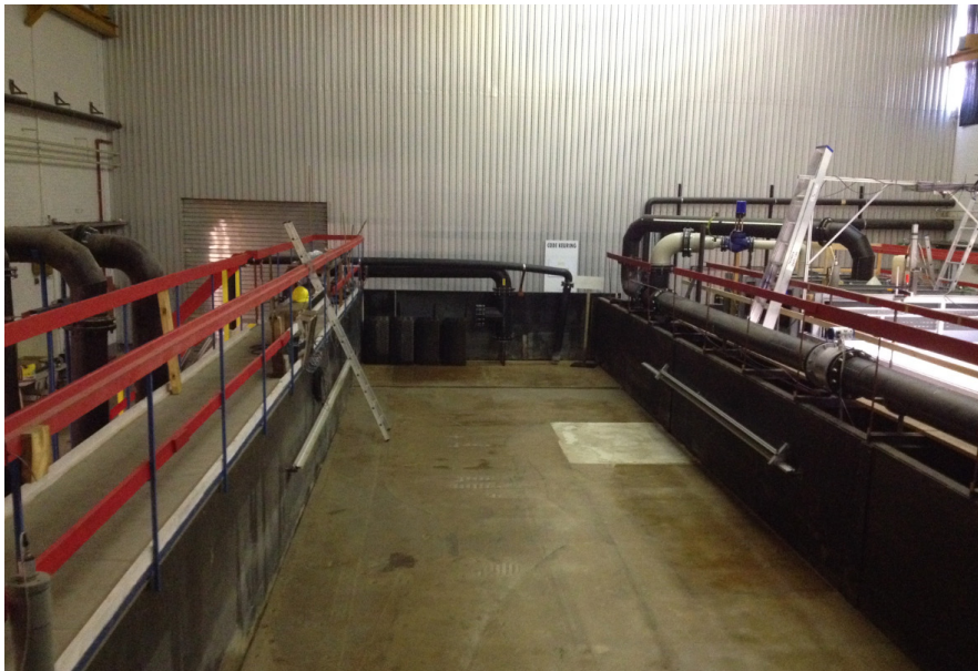
Figuur 108 – Proeftank A in Hal 2 van het Waterbouwkundig Laboratorium
