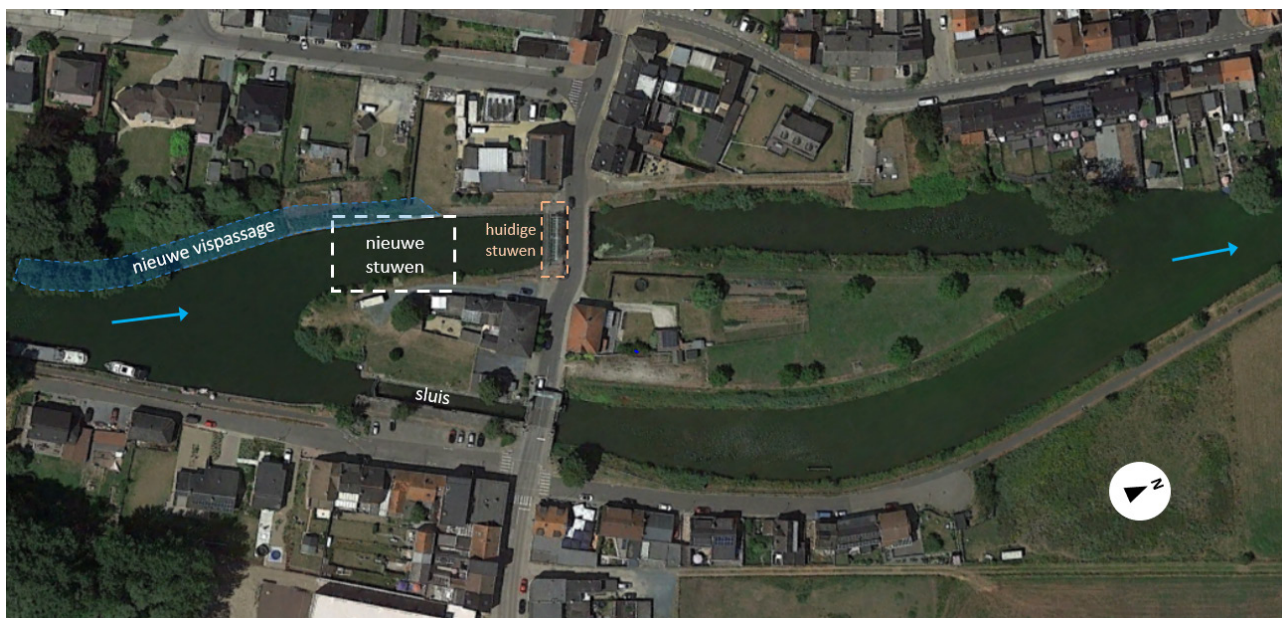
Figuur 7 – Luchtfoto huidige stuwsluiscomplex op de Dender te Denderleeuw
