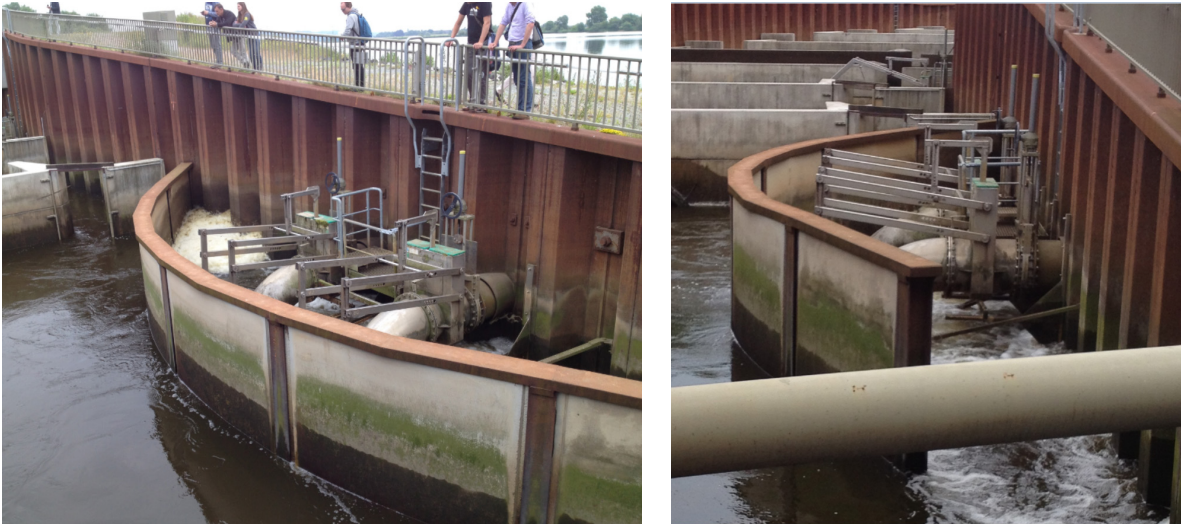
Figuur 17 – Voorbeeld voorkeur uitvoering wanden toegevoegd debiet
