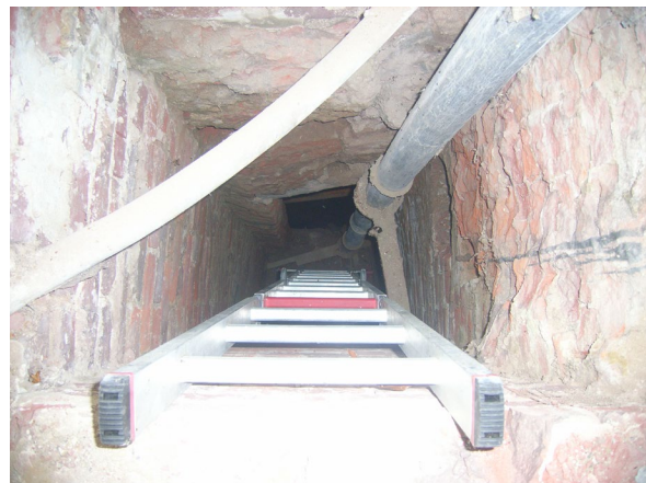
Figuur 12: Bovenaanzicht op de verticale schacht. © Agentschap Onroerend Erfgoed.
