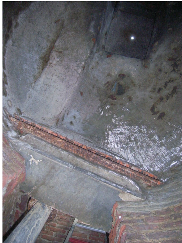
Figuur 6: Binnenzicht van de waterput – de boog correspondeert met de muur van de gevel van het bijgebouw. © Agentschap Onroerend Erfgoed
