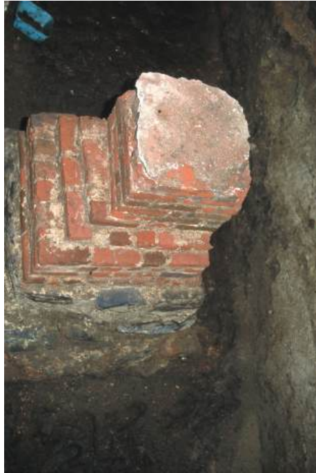
Fig. 4: Bakstenen fundering van een standvink van het 15de-eeuwse vleeshuis (© Stadsarcheologie Gent, OC_00304). The brick support of a tie-beam from the 15th-century Meat Hall (© Stadsarcheologie Gent, OC_00304).
