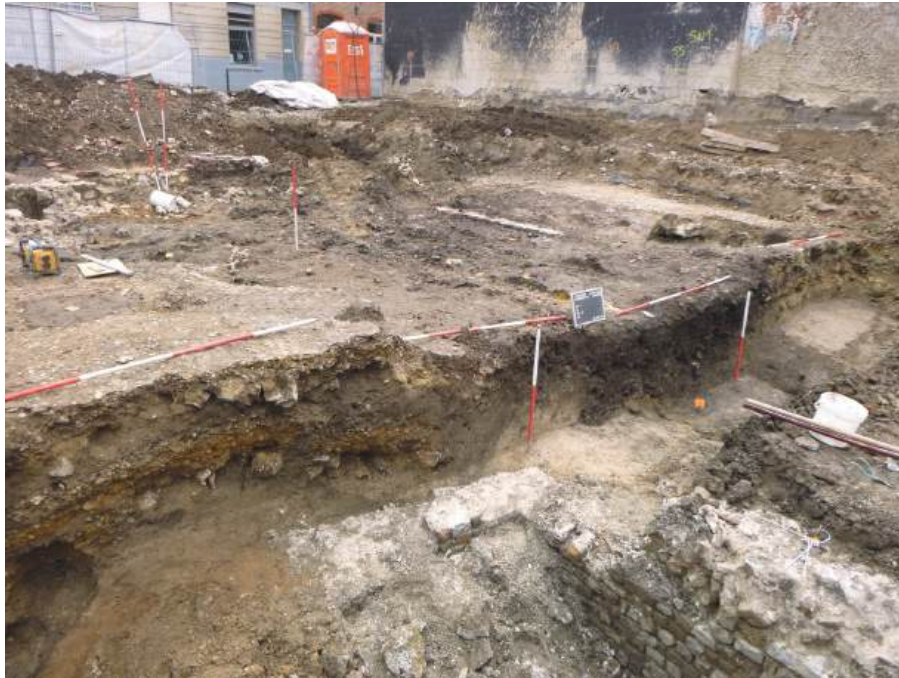
Fig. 2: Tongeren: Hondstraat: overzichtsfoto van de dubbele cardo, gezien vanuit het noordoosten (© BAAC Vlaanderen). Tongeren: Hondstraat: overview picture of the double cardo, seen from the northeast (© BAAC Vlaanderen).
