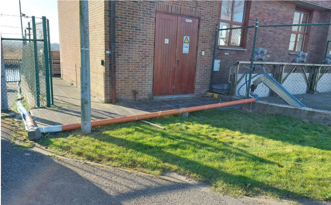
Figuur 10 Permanente goot (rechts) en experimentele geleidingsbuis die de glasalen en elvers tot in de polder leidt.
