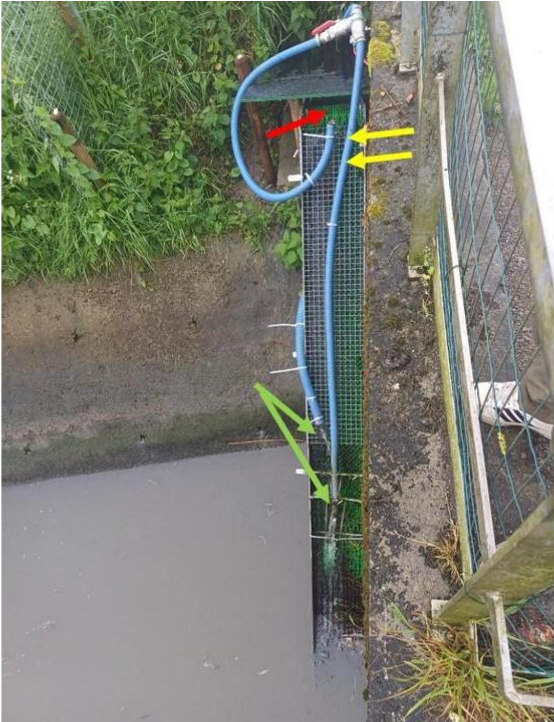
Figuur 36 Hoe het beter moet. Bovenaanzicht van een palinggoot waarbij de waterstralen op de verschillende punten de goot niet over de volledige breedte beregenen waardoor het water ook niet over de volledige breedte door de borstelgoot noch over de volledige breedte richting de trechter naar beneden stroomt. De 'eel ladder flow' wordt bij deze goot gevormd door perforaties onderaan (niet zichtbaar) in de blauwe buis (gele pijlen), de twee andere flows worden ook getoond: twee 'plunging' flows (groene pijlen) en één 'flushing' flow (rode pijl).
