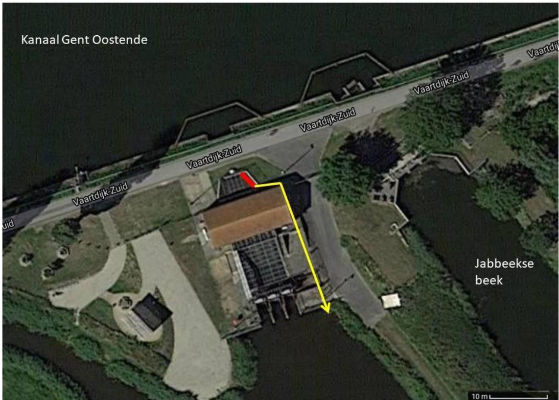
Figuur 9 De positie van de palingsgoot (rode lijn) ter hoogte van het pompgebouw Kwetshage-Paddegat. De gele pijl geeft de geleidingsbuis weer.
