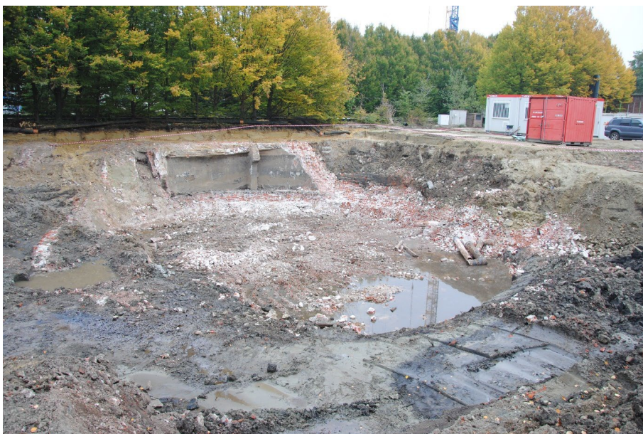
Figuur 16: Foto van de werkzaamheden in 2015, zicht vanuit het westen (© Anteagroup).
