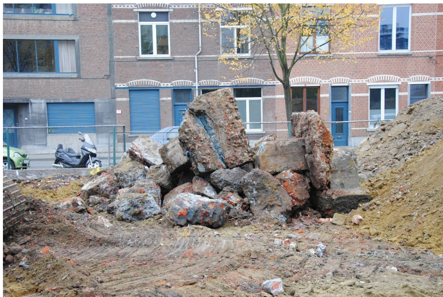
Figuur 15: Foto van uitgebroken muurresten tijdens de sanering in 2015 (© Anteagroup).
