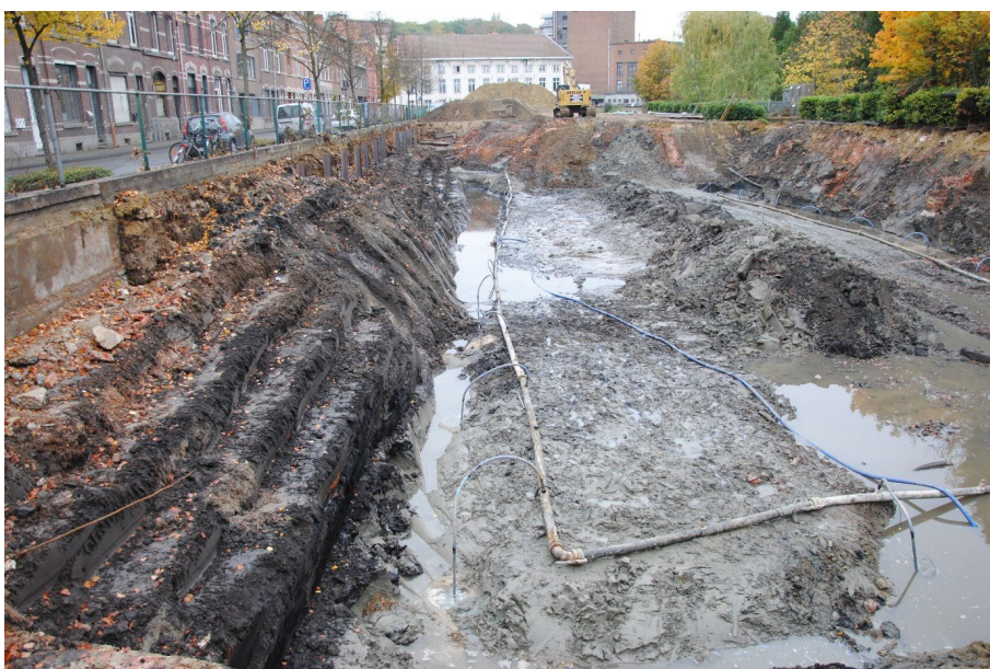
Figuur 17: Foto van de werkzaamheden in 2015, zicht vanuit het zuiden (© Anteagroup).
