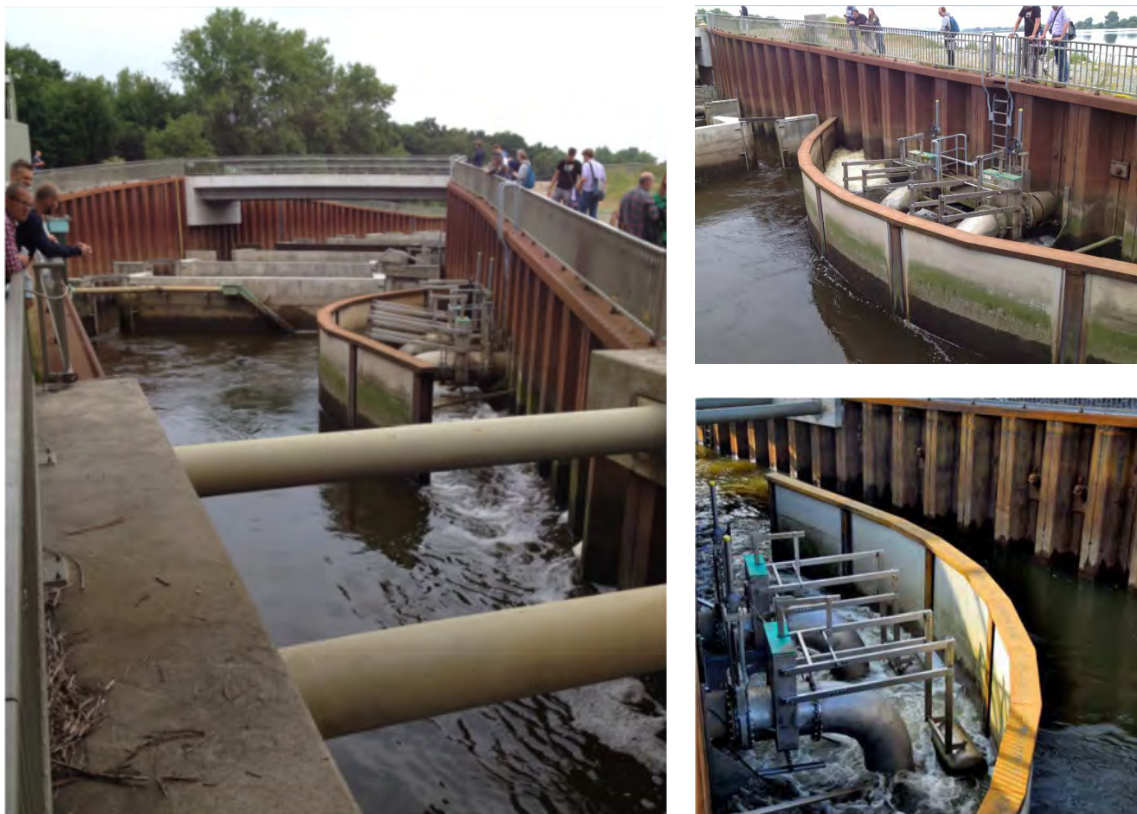
Figuur 75 – Foto's buizen toegevoegd debiet in het mondingskanaal van de dubbelslot-vispassage te Geesthacht
