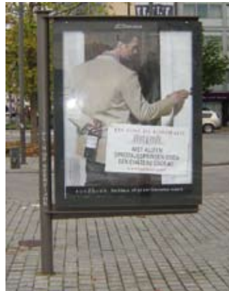
Fig. 2.1.1m De voet van deze reclamezuil is smaller dan het bord, waardoor witte-stokgebruikers het risico lopen tegen het bord te botsen, omdat ze het niet hebben opgemerkt met de stok.
