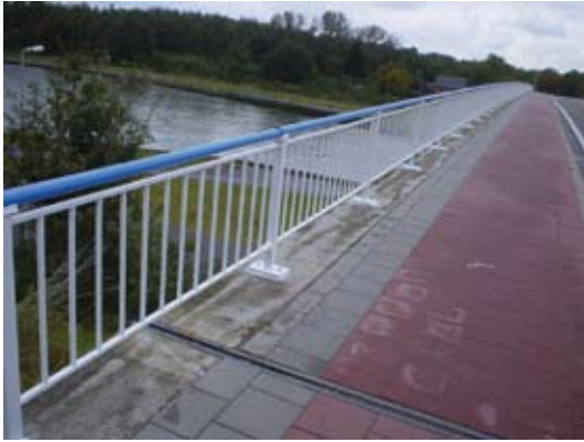
Fig. 2.1.4a7 Deze brugleuning heeft een goed contrasterende kleur
