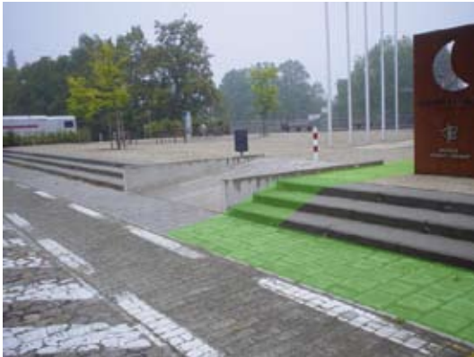
Fig. 2.1.4a3 Gesteld dat de groene loper de logische looproute is, zouden de dubbele leuning aan weerszijden van deze looproute moeten worden geplaatst.
