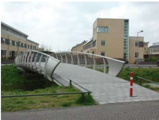
Fig. 2.1.4a8 Deze brugleuning is te kort, zodat het risico bestaat dat iemand voor de leuning langs naar beneden valt. Voor de veiligheid zou het beter zijn geweest als de leuning verder door zou hebben gelopen.
