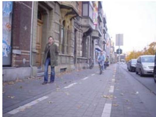
Fig. 2.1.3e Een gering hoogteverschil geeft een veel duidelijker onderscheid. Reeds een zeer klein hoogteverschil is voldoende als afbakening. De rand moet in ieder geval \leq 2\text{cm} zijn en afgeschuind onder een hoek van 45^\circ , zodat het geen obstakel vormt voor fietsers en het ook voor rolstoelgebruikers overrijdbaar is.
