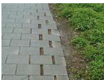
Fig. 2.1.3k De graskant langs een verharding kan dienen als een natuurlijke geleider. Zorg ook voor een goed onderhoud van de verharding. Met degelijke kantopsluiting en een gepaste fundering kunnen problemen zoals op de foto voorkomen worden.
