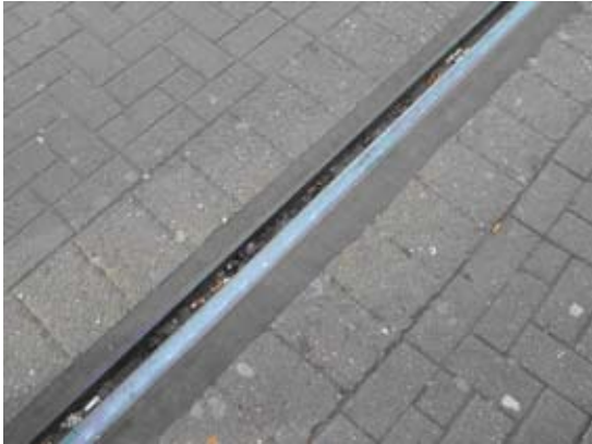
Fig 2.1.2b Tramspoor met kunststof opvulling van de opening tussen verharding en rail. De materialen kunnen werken zonder te beschadigen en de opening tussen bestrating en rail is weggewerkt.
