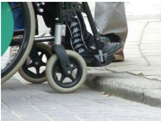
Fig. 2.1.4a Niveaunderschillen > 2cm zijn voor het merendeel van de rolstoelgebruikers niet zelfstandig overbrugbaar.
