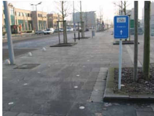
Fig. 2.1.3c Een afbakening van een fietsstrook met metalen noppen zoals hier werkt zeer verwarrend en is onvoldoende.
