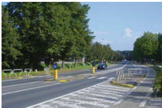
Fig. 2.2.1e Een middeneiland biedt de voetganger of fietser de mogelijkheid om de straat in 2 bewegingen over te steken.
