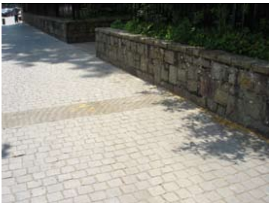
Fig. 2.1.3t Geleidelijnen sluiten aan op natuurlijke gidslijnen. De route die zo gevormd wordt heeft liefst een haakse patroon. Bij een haakse aansluiting van een kunstmatige geleidelijn op een natuurlijke gidslijn loopt de geleidelijn tot aan de gidslijn.
