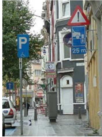
Fig 2.1.1i Om niet nog meer obstakels in de loopzone te moeten plaatsen heeft men in deze volle stedelijke omgeving de borden aan de gevel bevestigd. Ook de paal links 1 staat zoveel mogelijk buiten de loopzone, het bord is asymmetrisch aan de paal bevestigd.
