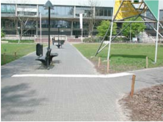
Fig. 2.1.3s Waar natuurlijke gidslijnen en kunstmatige geleidelijnen in elkaar overgaan moet er steeds een overlapping van ten minste 1m20 zijn.
