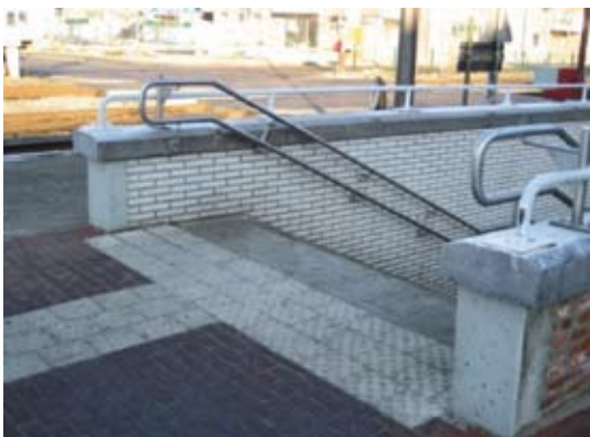
Fig. 2.1.3u Blinde en slechtziende personen kunnen trappen ervaren als valkuilen. Met een waarschuwingsmarkering kan de blinde of slechtziende voetganger worden gewaarschuwd voor het naderende trappengat. De markering wordt aangelegd over de volledige breedte van de trap. (zie 2.1.4.2 Buitentrappen).
