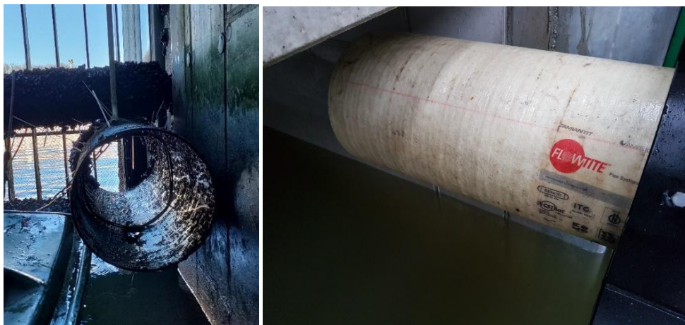
Figuur 8 Foto's van de buis waarlangs vis uit het omloopkanaal moet zwemmen om de stroboscooplampen te passeren. De buis heeft een diameter van 300 mm, en is gemaakt uit Flowtite type Amiantit: GRP: Glass Fiber reinforced Plastic.
