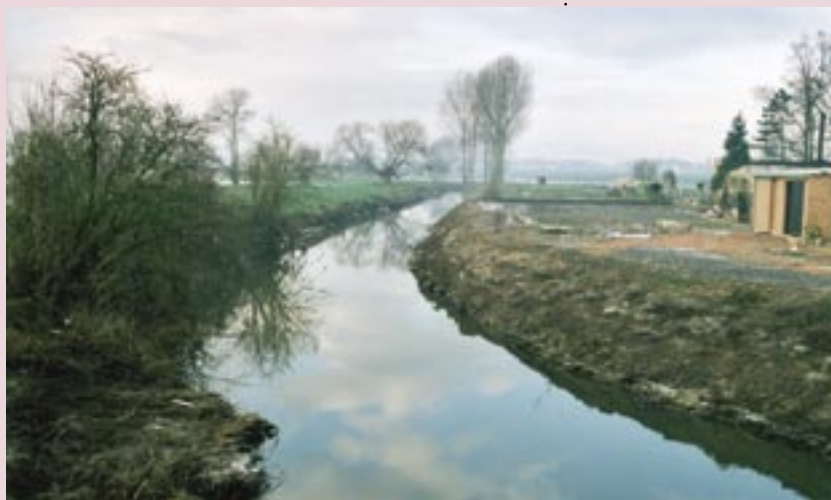
Krekelbeek afwaarts de Kronevoordestraat te Handzame, bij lage afvoer en na ophoping van de oever.
