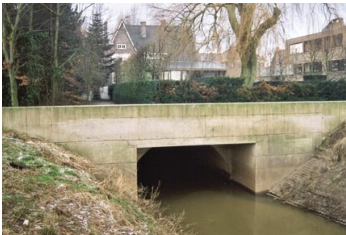
Opwaartse inlaat van de 230 meter lange overwelving van de Krekelbeek in het centrum van Kortemark.
