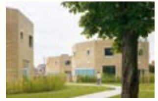
OO 2305 Project Sociaal woonproject Koksijde Plaats Kerkwijk, 8670 Koksijde Programma Sociale woningen, publieke ruimte Opdrachtgever OCMW Koksijde Ontwerp Puls architecten Bouwjaar 2021
