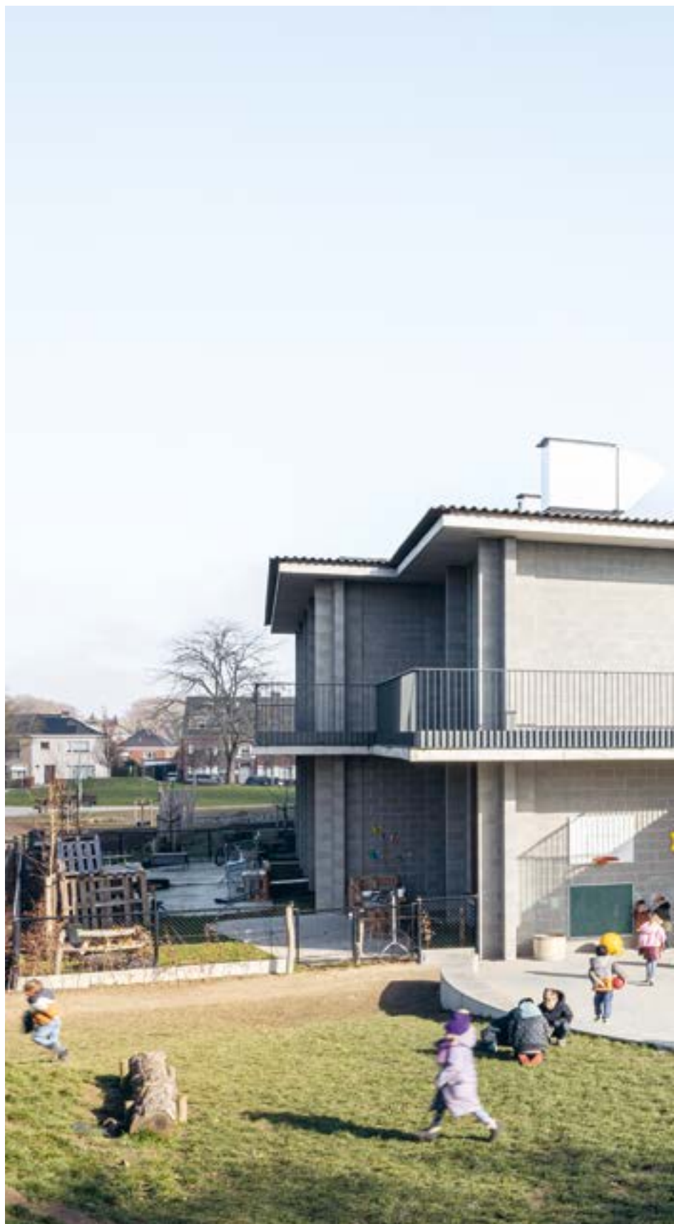
Aan de buitenzijde van het gebouw kraagt een rondgang uit. Elke klas geeft erop uit, net als de gemene zalen, maar ook twee trappen naar de speelplaats. © Tim Van de Velde
