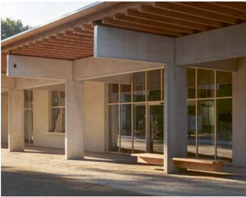
OO 3102 Onthaalgebouw Plantentuin Meise, NU architectuuratelier © Stijn Bollaert
