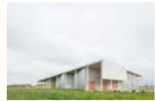
OO 2602 Project Crematorium Oostende Plaats Oude steenbakkerij, Grintweg 120, 8400 Oostende Programma Crematorium Opdrachtgever Opdrachthoudende vereniging voor crematoriumbeheer arrondissement Oostende Ontwerp Office Kersten Geers David Van Severen Bouwjaar 2021
