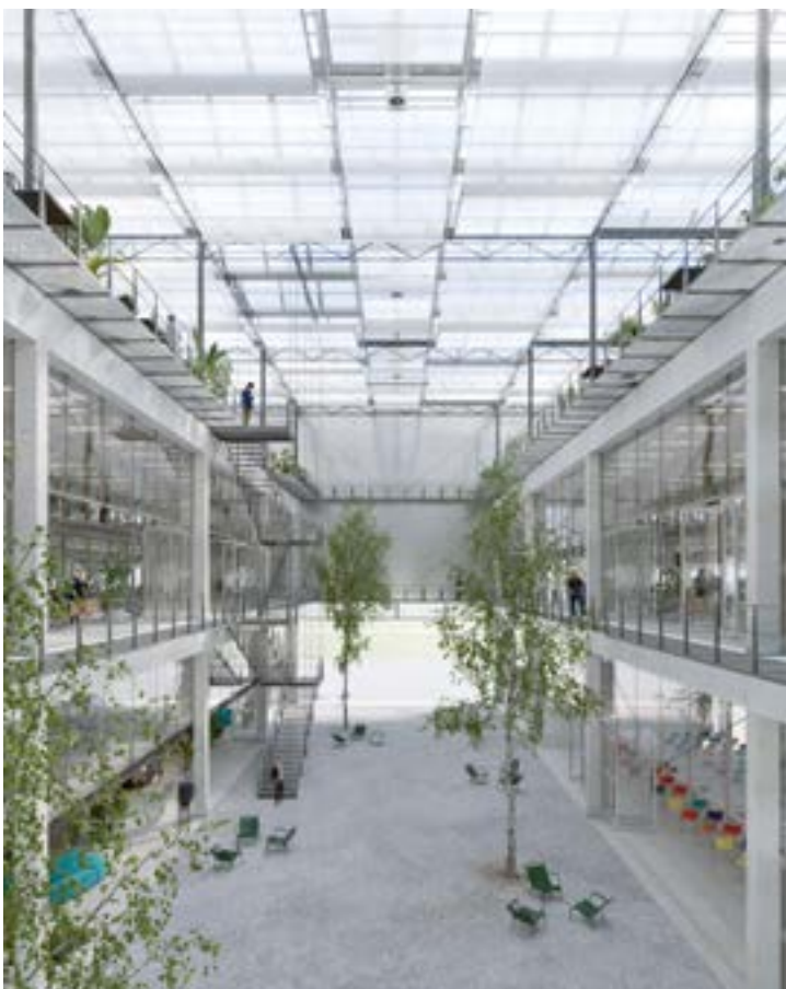
Baukunst zette het meest in op een heldere, aanpasbare structuur. Ze plaatsten twee modulaire volumes van dubbelhoge etages met daktuin en -terrassen aan weerszijden van een niet-geklimatiseerde doorgang en deden het geheel af met een serredak.
