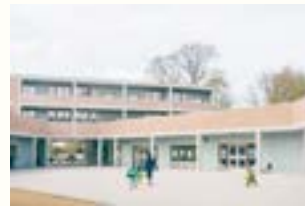
OO 2412 Project Dienstencentrum Zedelgem Plaats Koning Albertstraat 9-11, 8210 Zedelgem Programma Dienstencentrum, woningen Opdrachtgever OCMW Zedelgem Ontwerp Haerynck en Vanmeirhaeghe architecten Bouwjaar 2022
