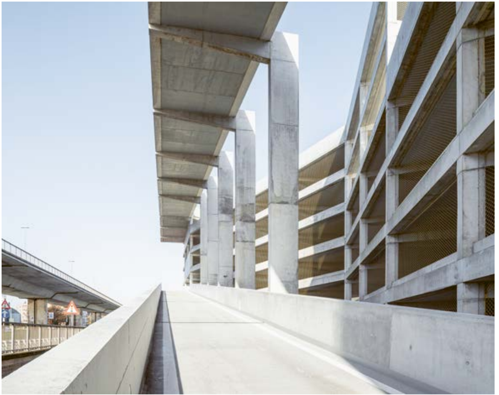
OO 2607 Parkeergebouw Ledeborg Gent, Bollinger + Grohmann, Haerynck Vanmeirhaeghe architecten, L.U.S.T. Architecten © Olmo Peeters
