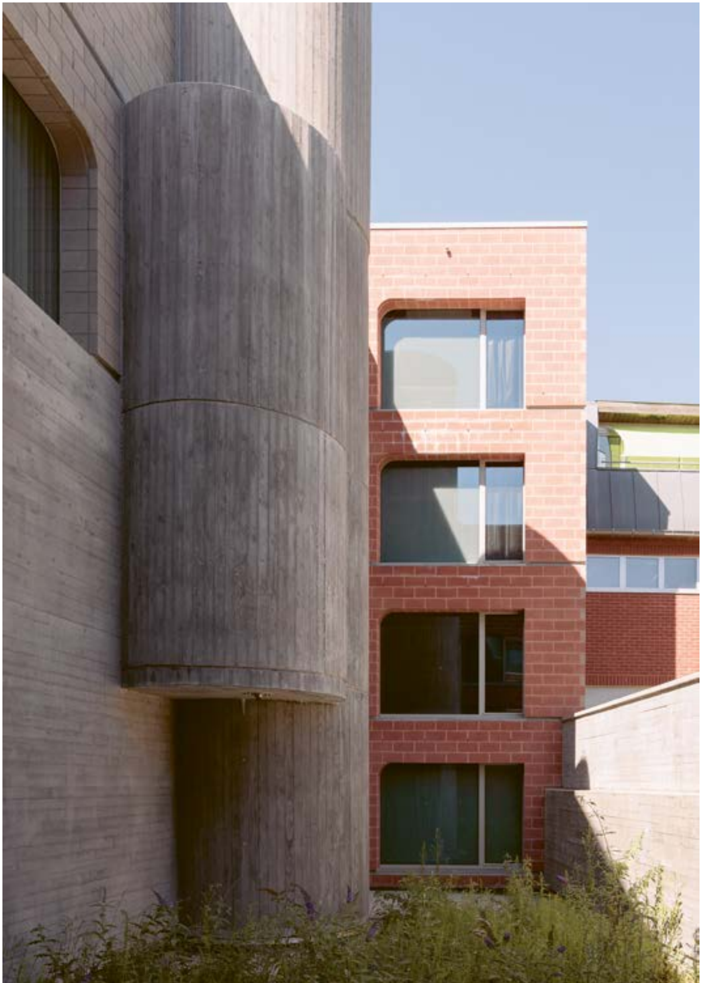
OO 2413 Brandweerkazerne en polyvalente zaal Dilbeek, Studio SNCDA et al. © Kaat Somers
