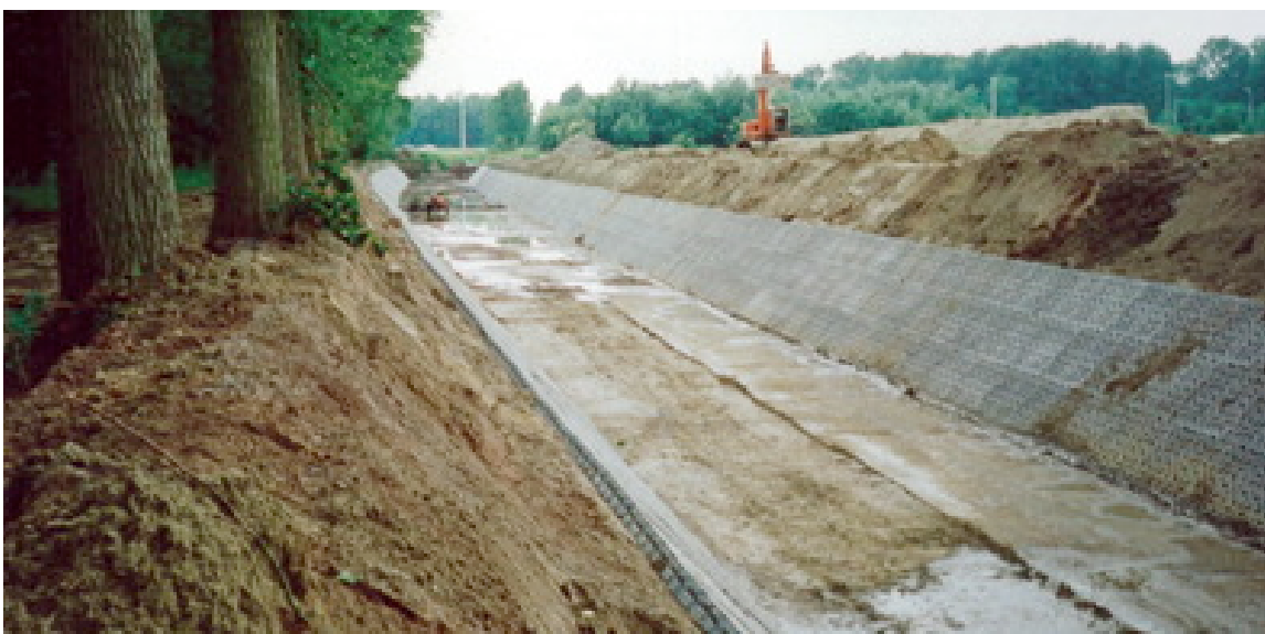
Foto van de aanleg van de zandvang op de Kerkebeek te Sint-Michiels. De rechtlijnigheid is aangewezen voor een goed bezinkingsproces van het meegevoerde zand. De oever- en bodembescherming moet gemakkelijke machinale ruiming garanderen.
