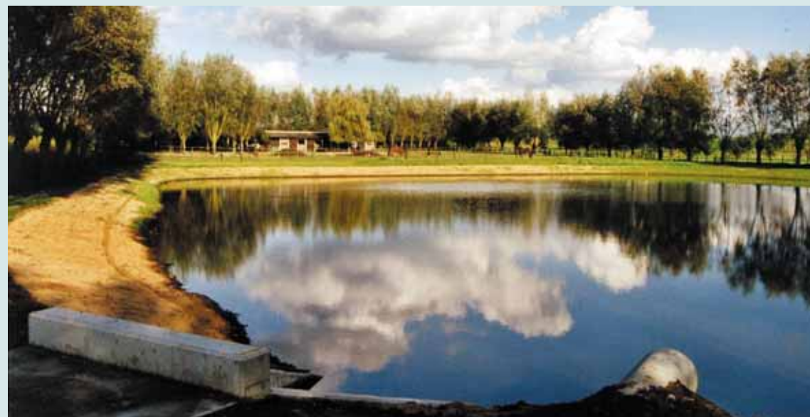
Pompboezem in Lokeren ter hoogte van de monding van de Ledebeek in de Durme. Zoals de naam zegt, vooral bedoeld om de werking van het vijzelgemaal te verbeteren: de pompen zullen veel minder moeten aan- en afslaan dan wanneer zij rechtstreeks het sterk fluctuerend debiet van de Ledebeek moeten verpompen. Enkel heel grote pompboezems kunnen ook als wachtbekken werken, waarbij een overmaat aan water een bepaalde tijd kan gestockeerd worden.
