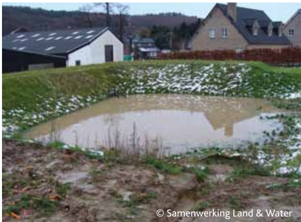
Dam met erosiepoel
