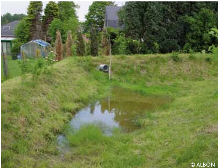
Dam met erosiepoel
