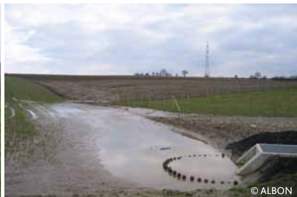
Dam met erosiepoel
