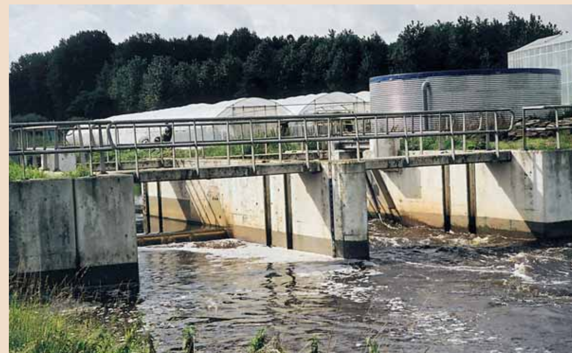
Stuw nr. 6 (Het Looi). Stuwen zijn hydraulische infrastructuur die een belangrijke rol spelen in het gedrag van watersystemen en als zodanig dan ook een belangrijk onderdeel vormen van de computermodellen.
