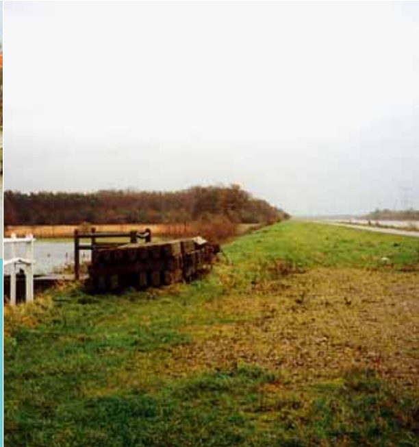
Inlaten van de sifons van de Bollaak (wit hekwerk vooraan) en de Molenbeek of Kleine Beek (bruin hekwerk) onder het Albertkanaal met jaagpad (rechts in beeld).
