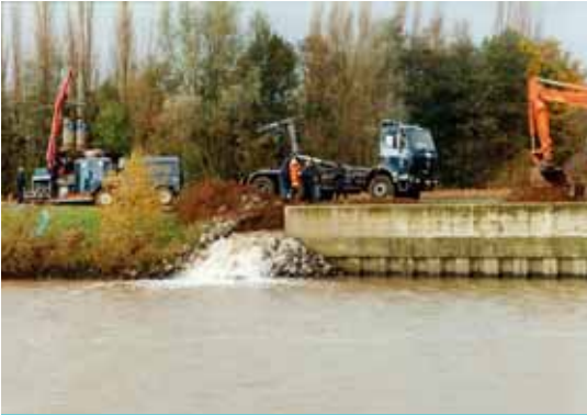
De civiele bescherming pompt water van de Bollaak over naar het Netekanaal, teneinde de grootste druk op enkele woningen weg te nemen (september 1998).
