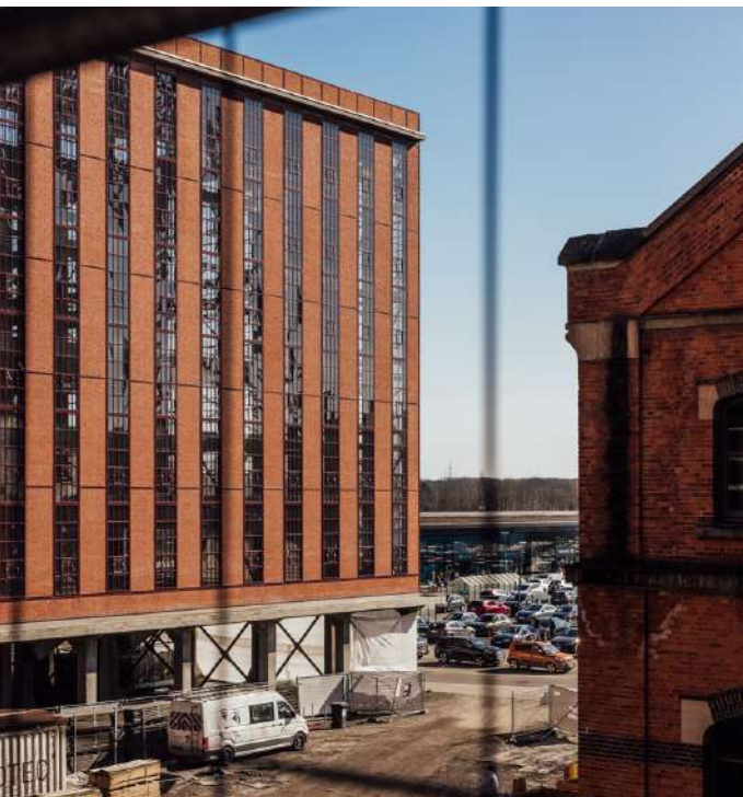
↑Er wordt hard gewerkt aan de transformatie van be-MINE.
