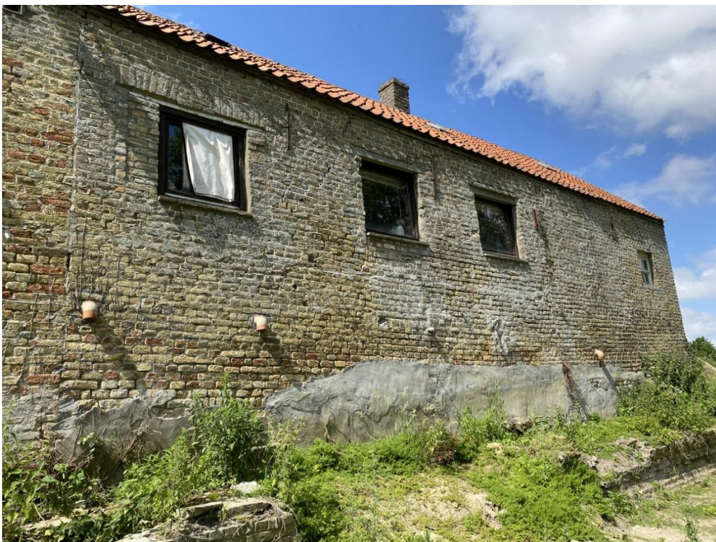
De zuidgevel van de 19 de eeuwse aanbouw. Het linkervenster komt op de plaats van twee gedichte vensters.
