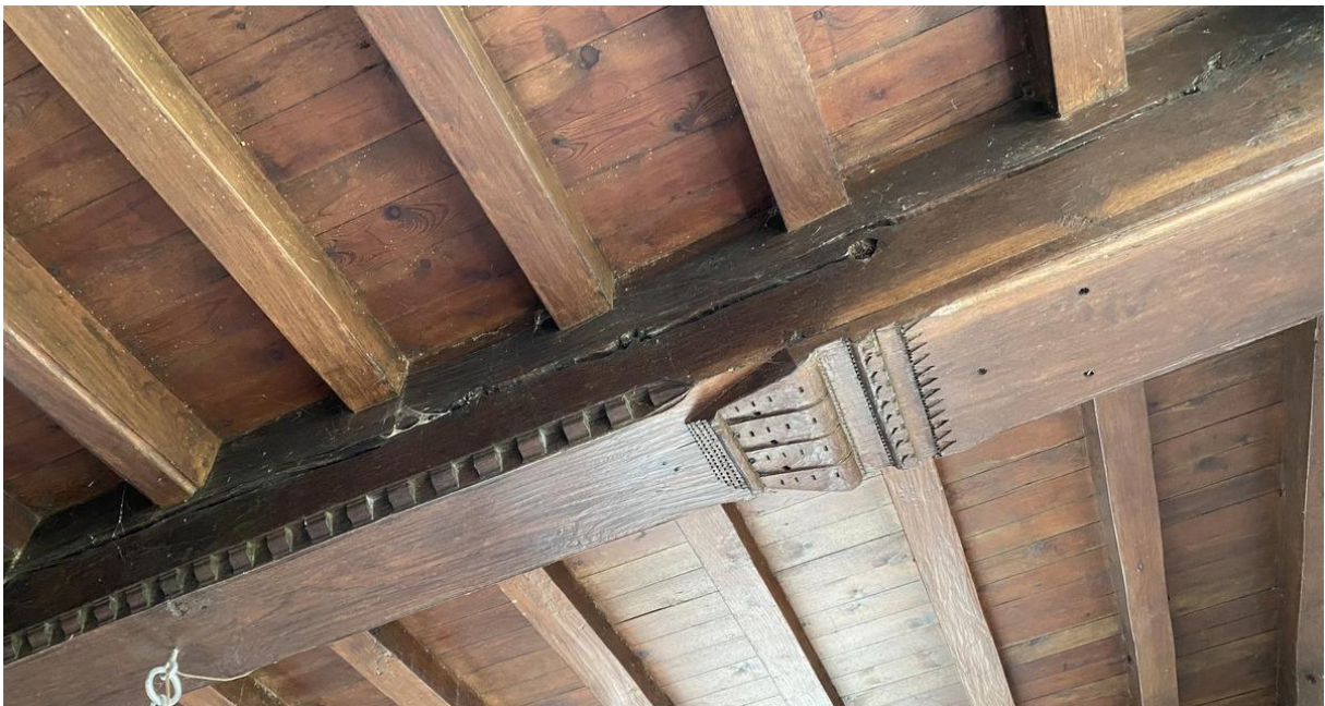
De oostelijke balkconsole van de noordelijke kamer. De nagelgaten rechts tonen de plaats van de verdwenen sierspijkers.
