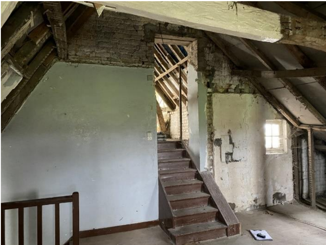
De scheidingsmuur tussen de beide zolders met de zoldertrap naar de zolder van de hoofdvleugel.
