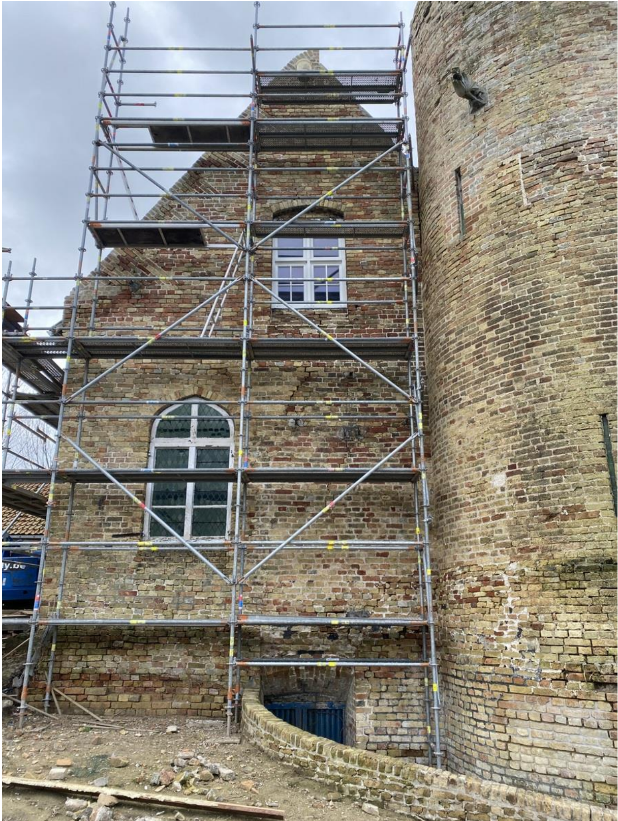
De noordelijke korte gevel.
