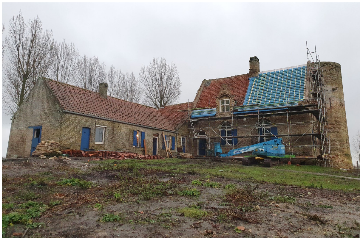
Figuur 12: Torreelen tijdens het onderzoek in december 2023. Zicht vanaf de binnenplaats (© agentschap Onroerend Erfgoed).
