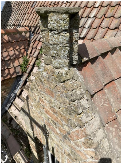
Details van de begin 20 ste eeuwse dakkapellen van de westgevel
