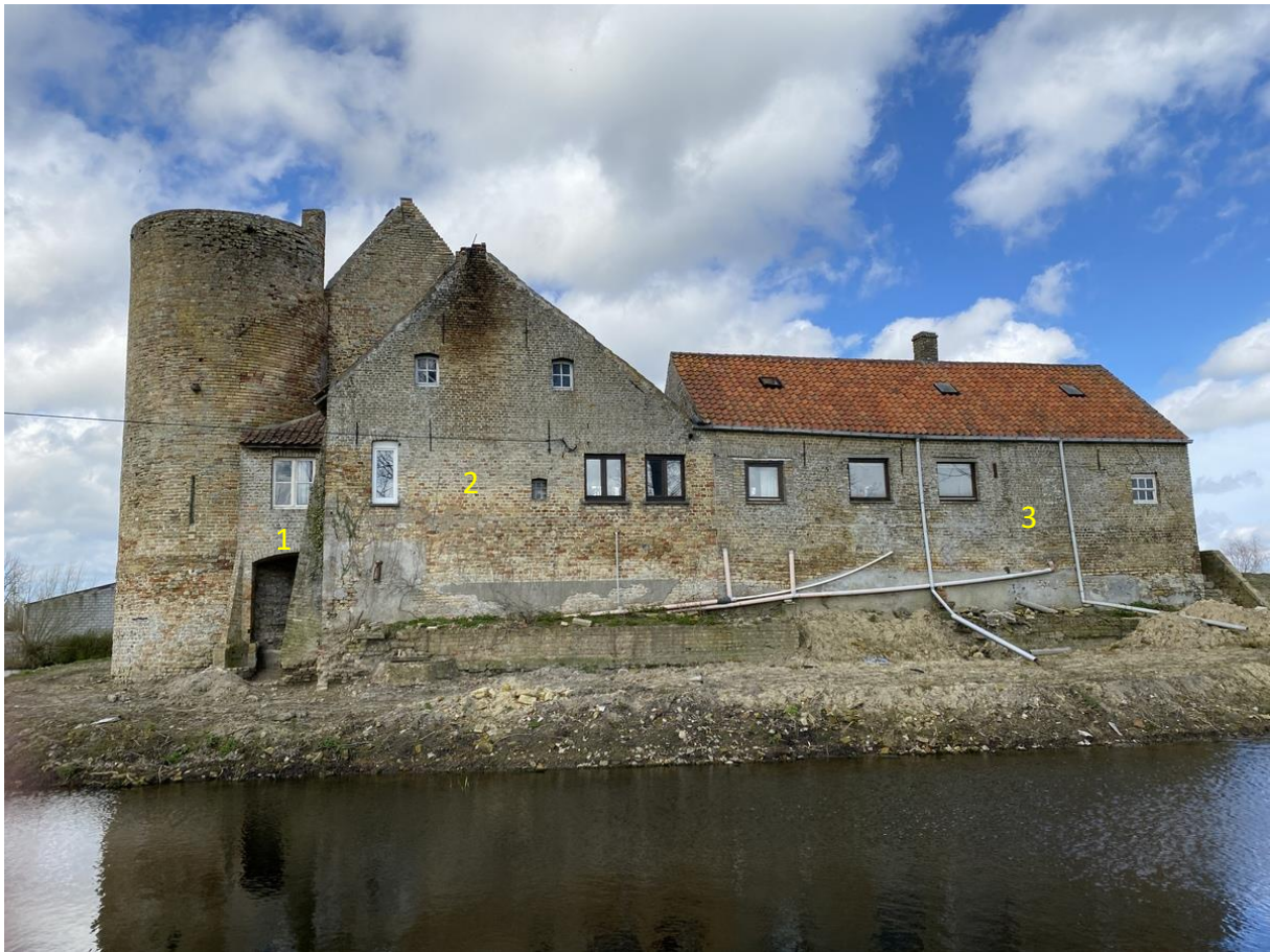
De site gezien vanuit het zuiden met het verbindingsgebouw (1) de 18 de eeuwse zuidvleugel (2) en de 19 de eeuwse haakse vleugel (3).
