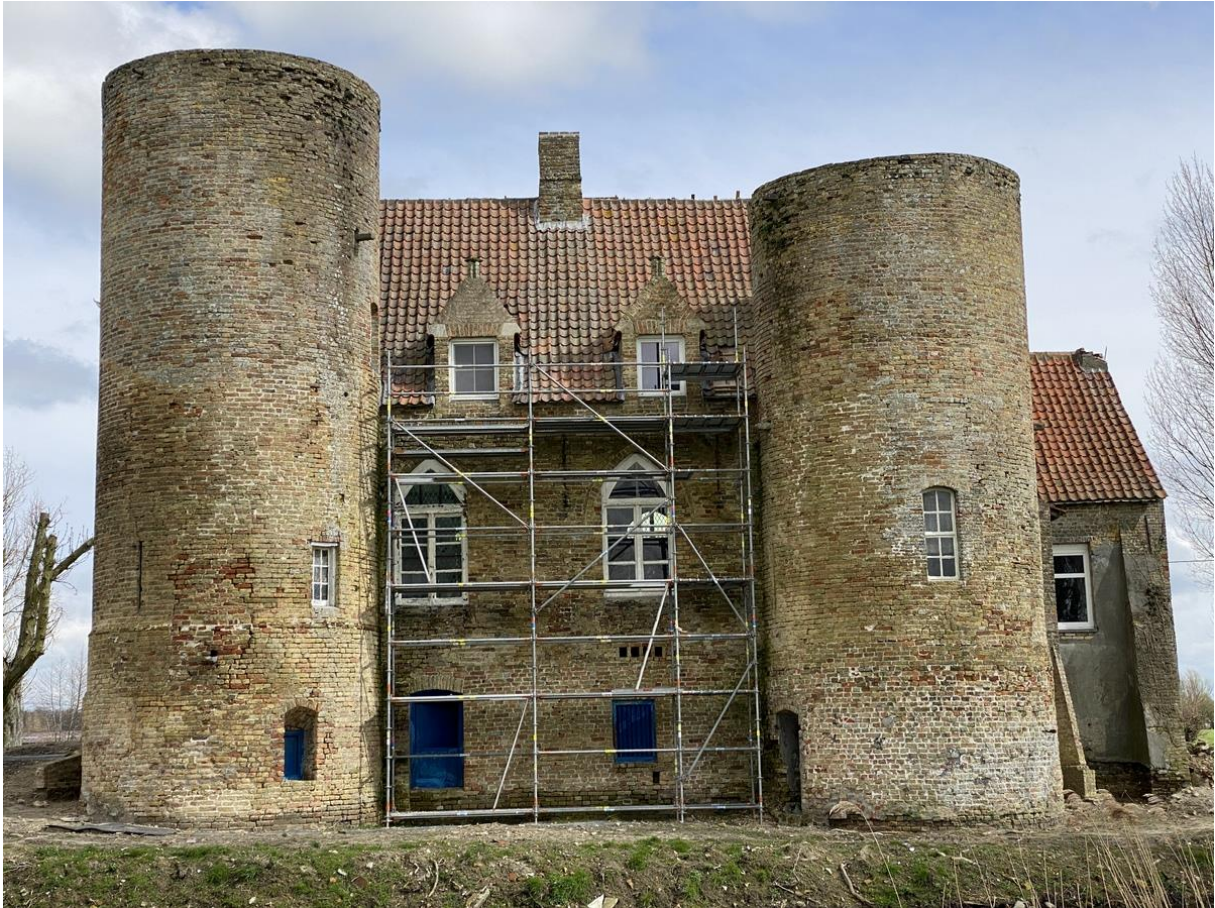
De westelijke gevel van het woonhuis
