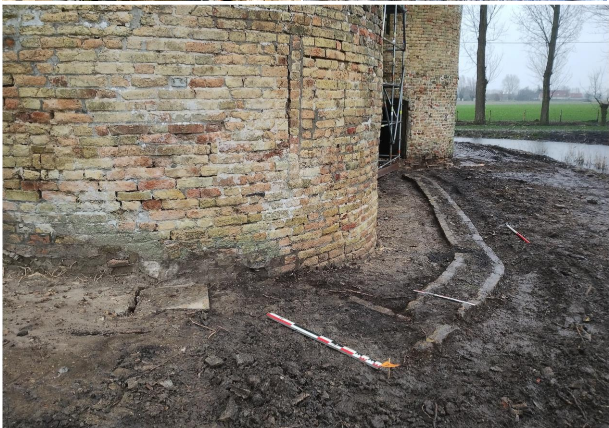
De resten van de bekisting van de waterleiding aangelegd eind 1917- begin 1918 (uit Gils & De Decker, 2024, p.12).
