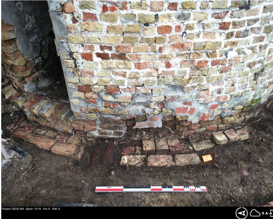
Figuur 48: Zone 3: fundament van de zuidwestelijke toren (S15) (© agentschap Onroerend Erfgoed).
