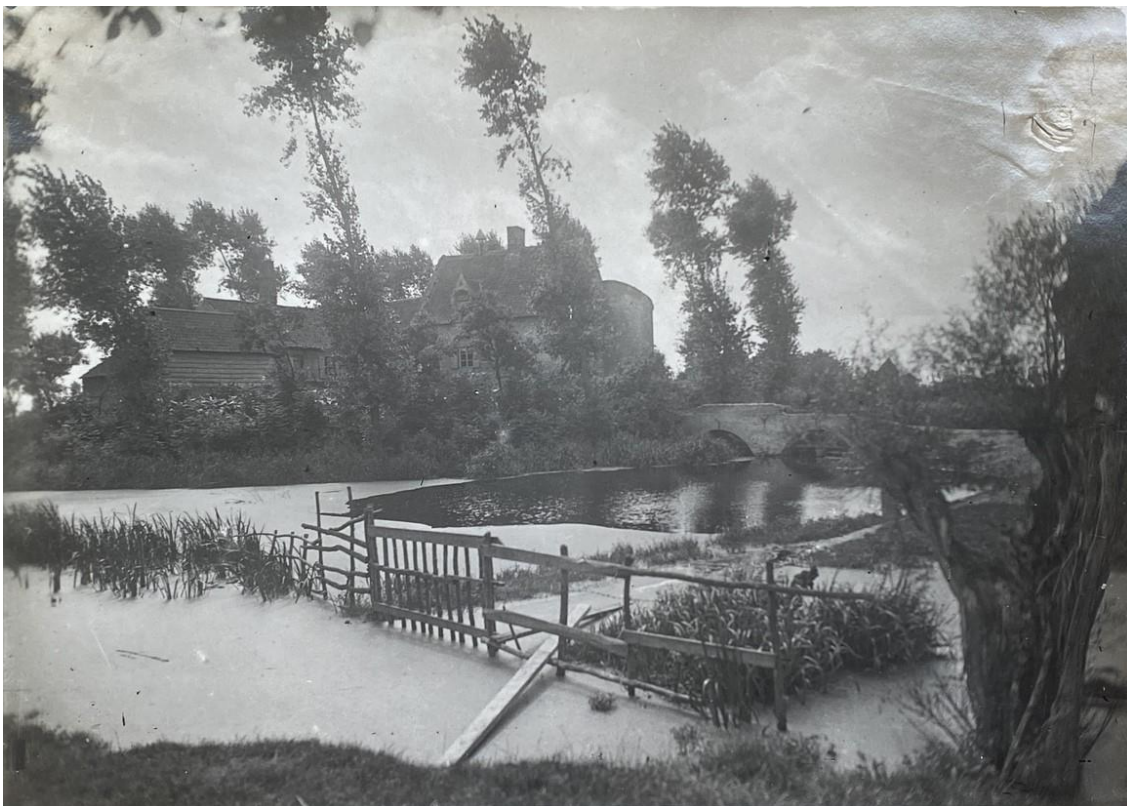
De hoeve, gezien vanuit het NO, 1917 (najaar?). Het water van de walgracht staat bijzonder hoog (Veurne, Archief, Aanwinstendossier, 474).
