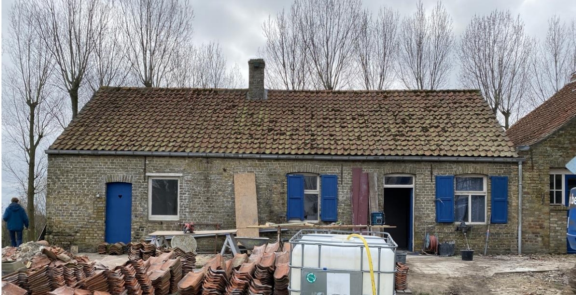
De erf- of noordgevel van de 19 de eeuwse aanbouw
