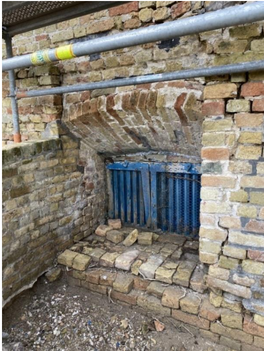
Het keldervenster in de noordgevel.
