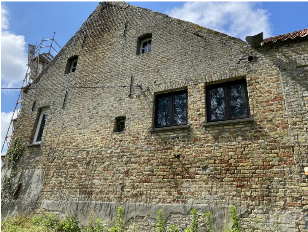
De zuidelijke gevel van de 18 de eeuwse aanbouw
