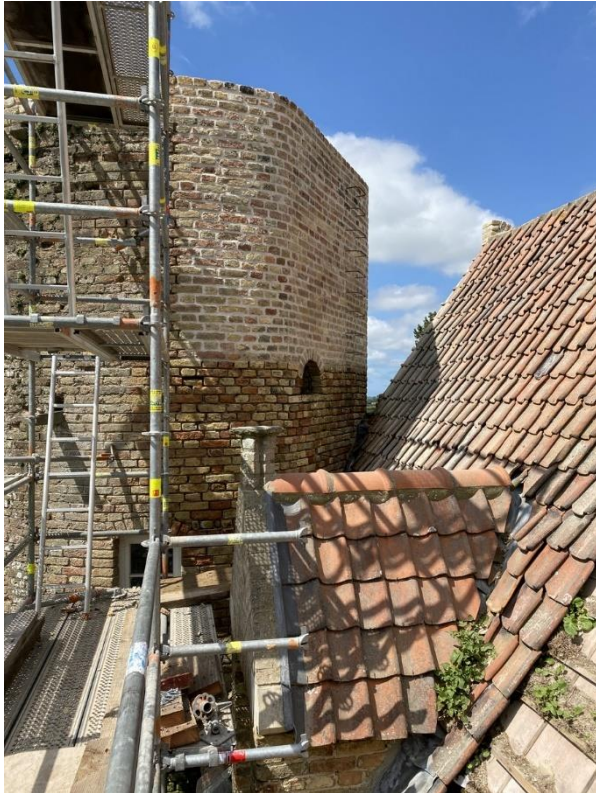
Het herbouwde bovendeel van de noordelijke toren. In de achterzijde is een rondboogopening aangebracht. Onder: de rondboogopening met in de doorkijk de onderbouw van de citerne
