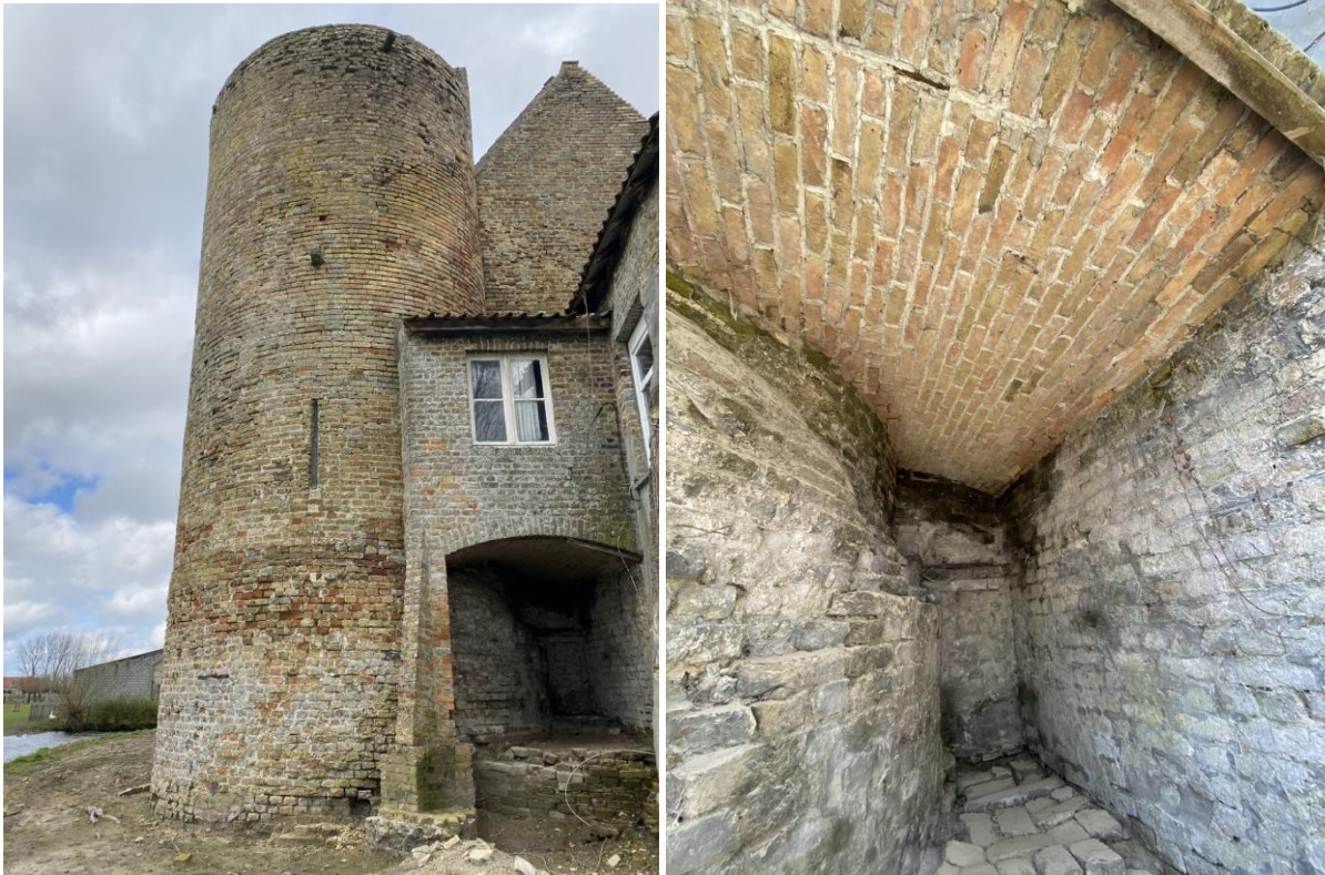
Het verbindingsgebouw tussen de toren en de zuidvleugel. Links: algemeen zicht; rechts: de overdekte ruimte.
