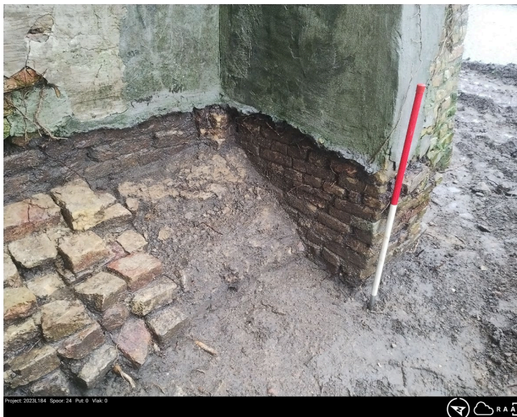
Figuur 45: Zone 2: Mortelpakket S23 (© agentschap Onroerend Erfgoed).
