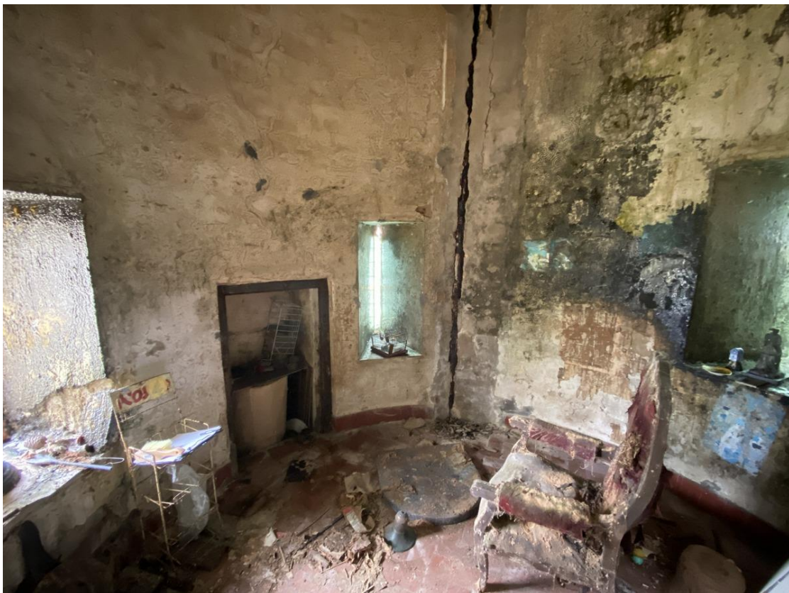
De torenkamer van de tweede bouwlaag (gelijkvloerse verdieping) van de noordelijke toren.
