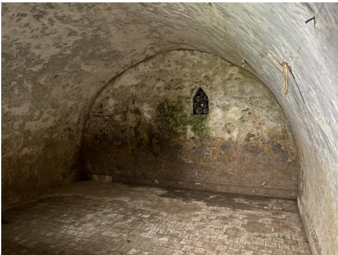
De noordelijke kelder. De vloer en de plint zijn belegd met kleine roodgebakken tegels, geschrinkt gelegd.
