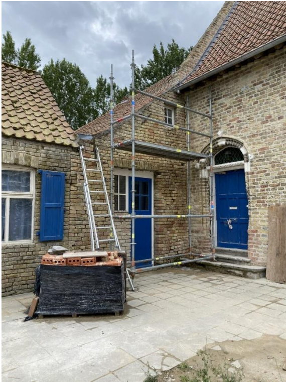
De hoek tussen het hoofdgebouw en de 18 de eeuwse vleugel (juli 2024)
