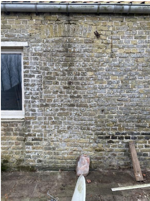
De zuidvleugel; gedichte deur in de erfgevel
