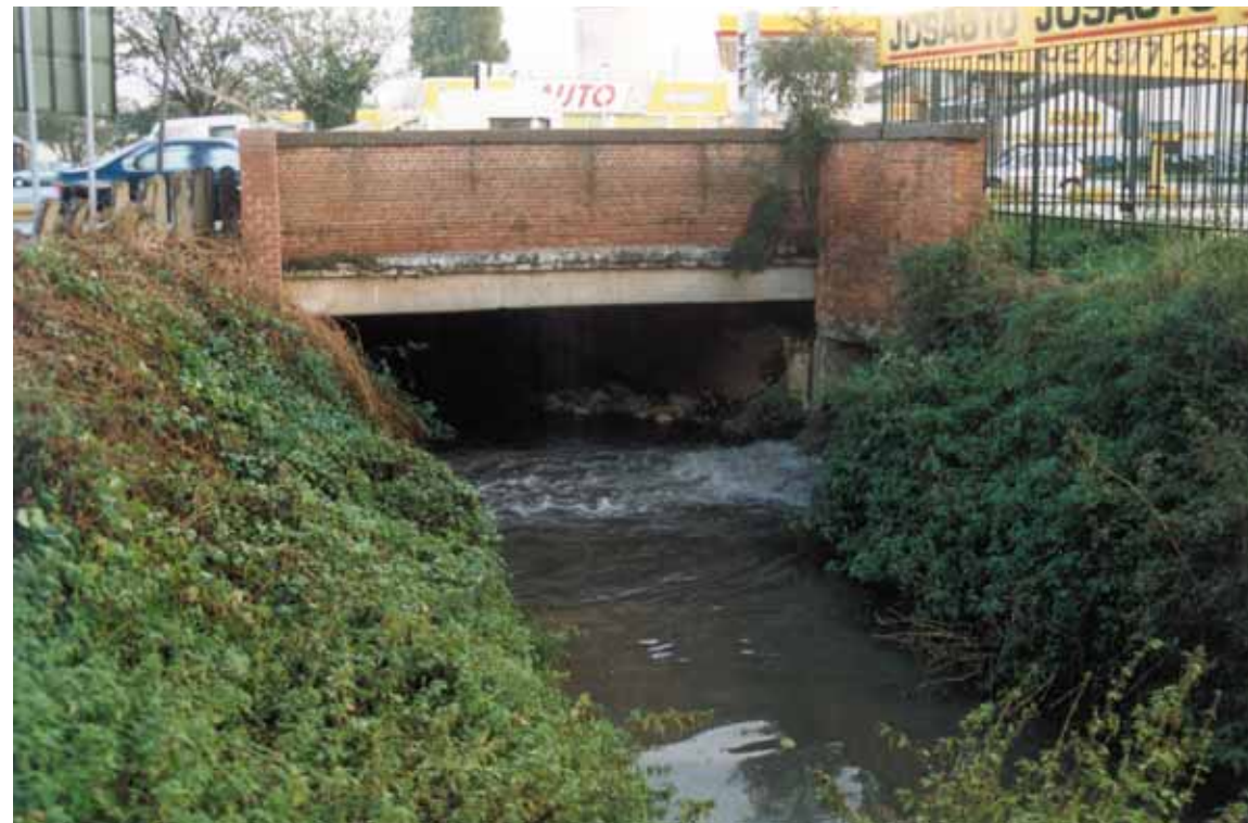
Opwaartse ingang aan de Bergensesteenweg van de 380 meter lange overwelfing van de Zuunbeek onder de parking van warehouse Carrefour.
