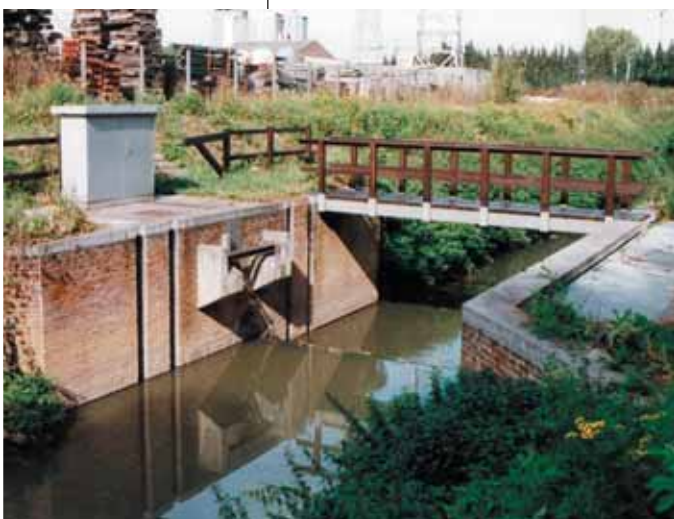
In 1987 werden op de rechtgetrokken benedenloop van de Zuunbeek 11 klepstuwen geplaatst, zoals ter hoogte van de Oudstrijdersstraat volledig afwaarts (foto links) en juist opwaarts de Kerkhofstraat (foto rechts).
