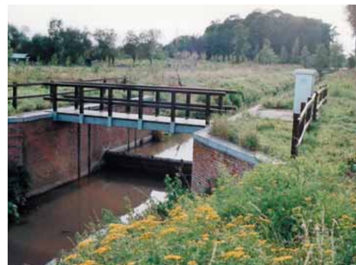
In 1987 werden op de rechtgetrokken benedenloop van de Zuunbeek 11 klepstuwen geplaatst, zoals ter hoogte van de Oudstrijdersstraat volledig afwaarts (foto links) en juist opwaarts de Kerkhofstraat (foto rechts).
