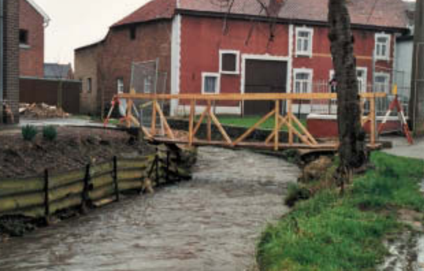
Brug in het centrum van 's-Gravenvoeren weggespoeld na hevige neerslag.
