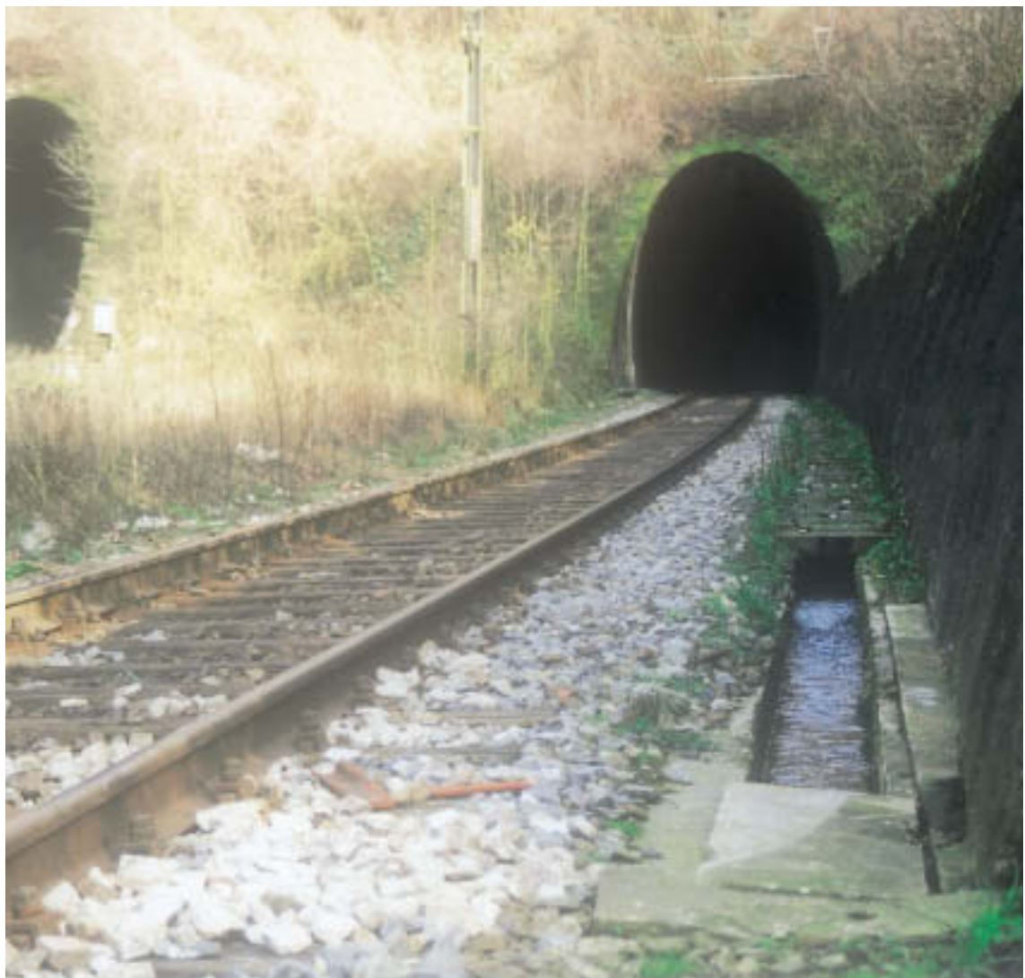
Door de aanleg van de spoorwegtunnel in het begin van de 20ste eeuw in het gehucht Veurs is een oorspronkelijke bron van de Veurs beïnvloed. Het bronwater komt nu via twee greppels uit de spoorwegtunnel.
