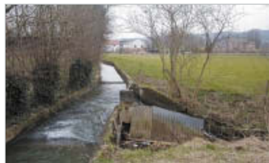
Stuw op de Voer met afleidingskanaal naar de visvijvers te Berg.
