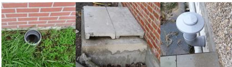
Figuur 57: Ontluchtingsmogelijkheden bij een mestkelder.
