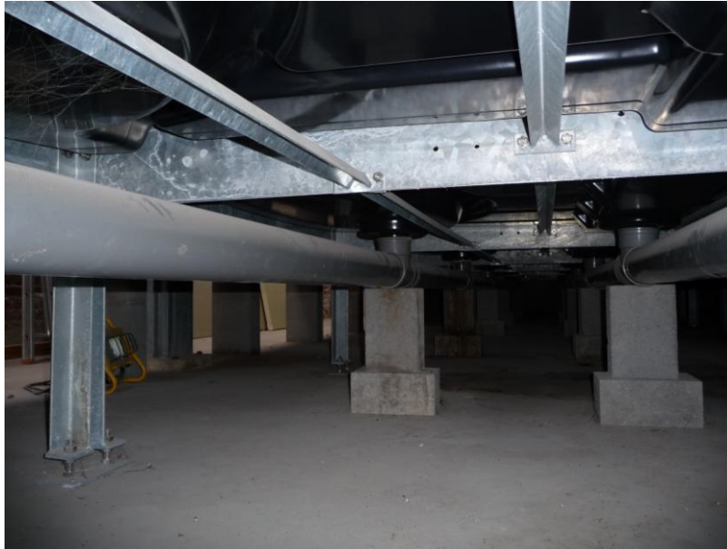
Figuur 53: rioleringsysteem gesteund op betonblokken.
