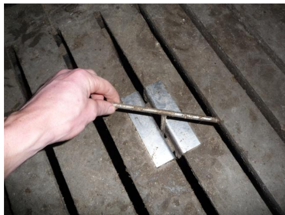
Figuur 46: Trekstang ingewerkt in de roosterspleet.
