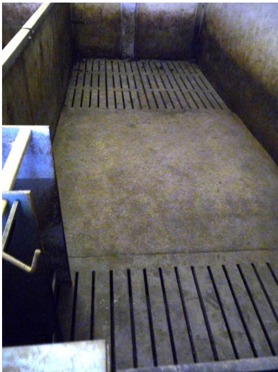
Figuur 6: Bolle vloer.
