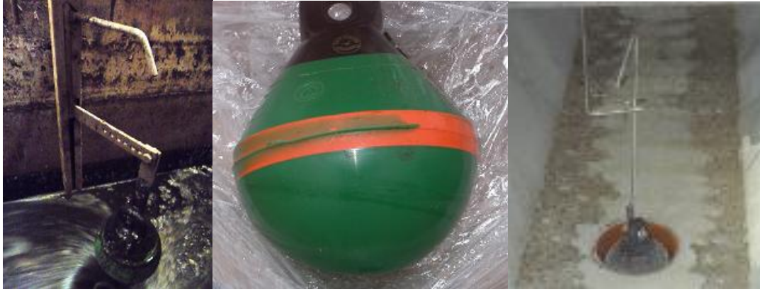
Figuur 43: Bolafsluiter en bevestigingssysteem.
