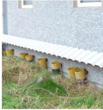
Figuur 49: Reinigingsopeningen van een rioleringsysteem.
