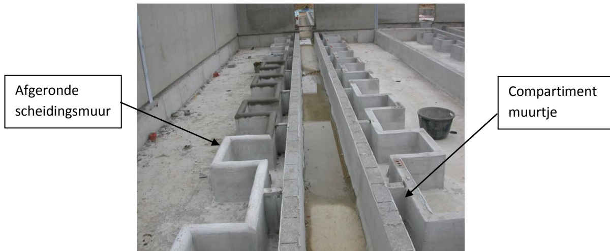
Figuur 30: Gecompartimenteerd mestkanaal en afgeronde scheidingsmuren.
