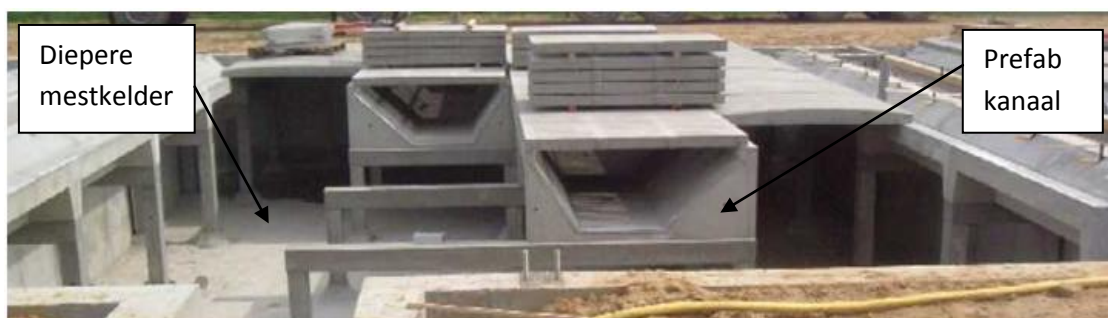
Figuur 3: Prefab kanalen.
