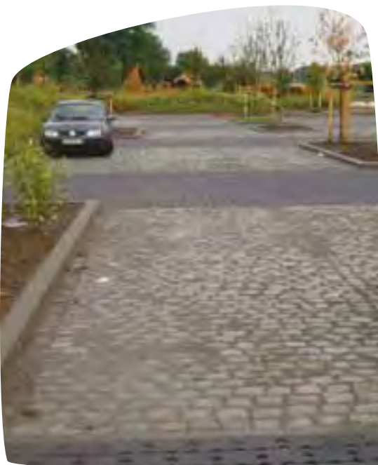
Parking aangelegd in waterdoorlatende betonstraatstenen
