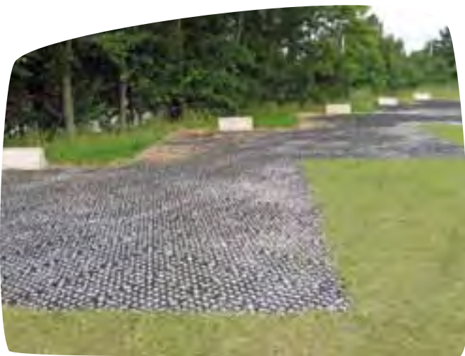
Een busparking waarbij de kunststofplaten afwisselend met steenslag en gras opgevuld zijn om parkeervakken aan te duiden (Site Abdij van Herkenrode, Kuringen, Hasselt)
