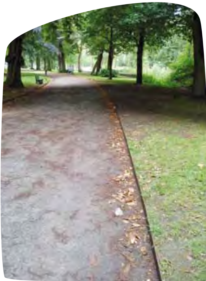
Opsluiting met een strook in (corten)staal
