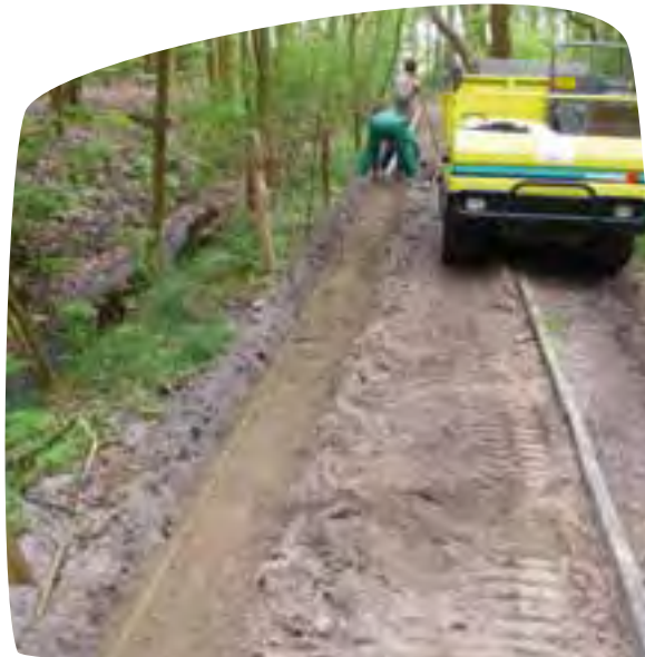
Aanleg van een boordsteen in beton Voor deze constructie is een fundering in schraal beton nodig over de volledige lengte van het pad (Duinbossen, Klemskerke, De Haan).
