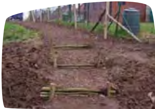
Trap van takken en houtsnippen (Lennik) Foto: Trage Wegen vzw
