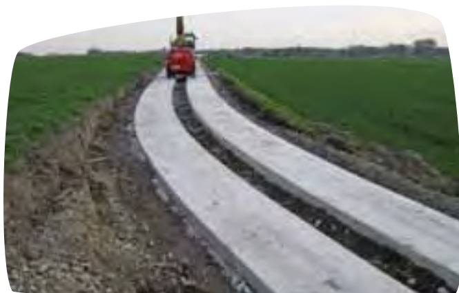
Een tweesporenpad in cementbeton tijdens de aanlegfase
