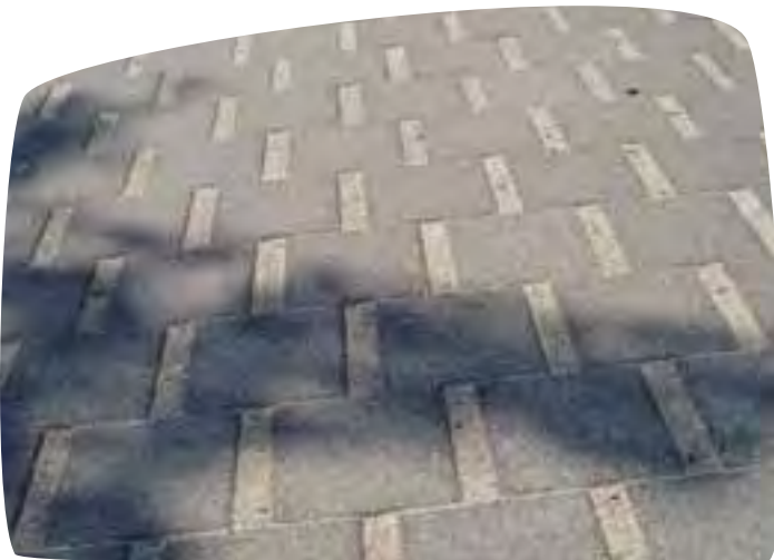
Deze parking is uitgevoerd in betonstraatstenen. De voegen zijn opgevuld met metaalslakken (een bijproduct van de metaalverwerkende industrie) (Kasteelpark Vordenstein, Schoten).
