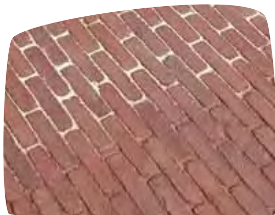
Verskil tussen een voegvulling met rivierzand (grijs) en een voegvulling met split (rood)
