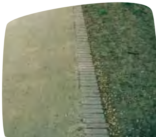
Opsluiting van een halfverharding met een rij gebakken straatstenen
