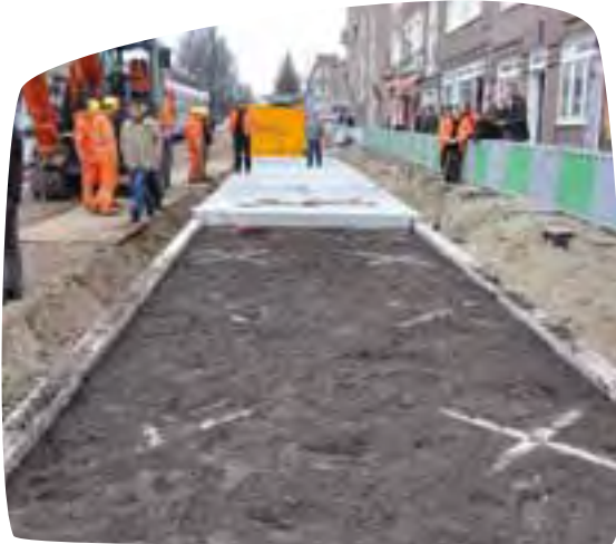
Aanleg van boombunkers (Rijnstraat, Amsterdam) Foto: Inverde
