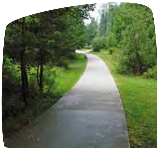
Pad uitgevoerd in cementbeton (Groene Vallei, Gent)
