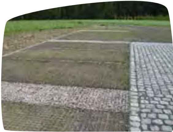
Parkeervakken aan een onthaalruimte (De Speelberg nabij het Meerdaalwoud, Oud-Heverlee) De vegetatie in de gras-kunststofplaten kan zich nog spontaan vestigen.
