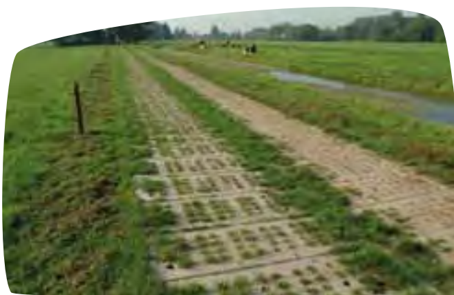
Het gebruik van geprefabriceerde geperforeerde betonplaten als tweesporenpad
