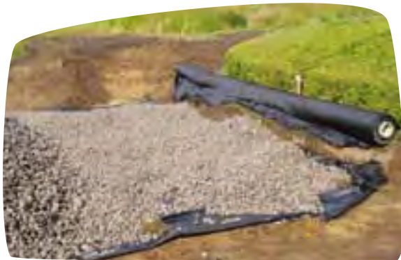
Het aanbrengen van geotextiel om vermenging met de ondergrond te vermijden en om de drainagecapaciteit van de fundering te behouden
