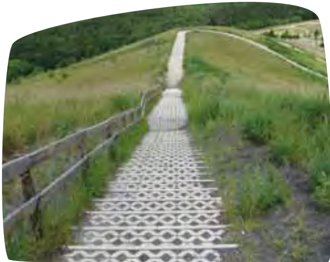
Trap opgebouwd uit grasbetontegels (optreden) en betonnen boordstenen (aantreden) (Mijnsite, Beringen)
