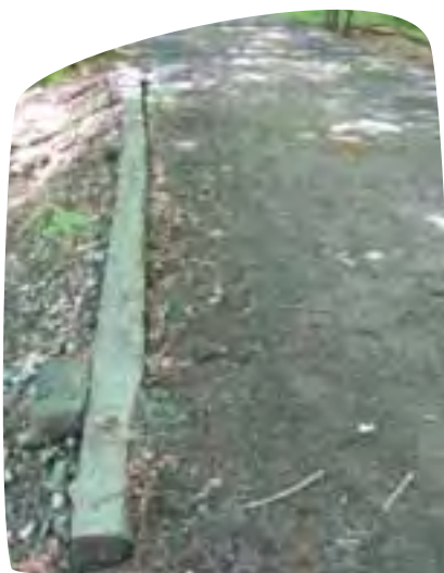
Opsluiting van een hellend pad, uitgevoerd in een halfverharding, met een eiken balk om erosie te voorkomen (Zoniënwood, Hoeilaart, Overijse)
