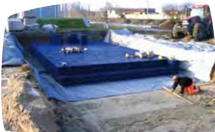
Aanleg van een constructie met infiltratiekoffers Foto: Inverde
