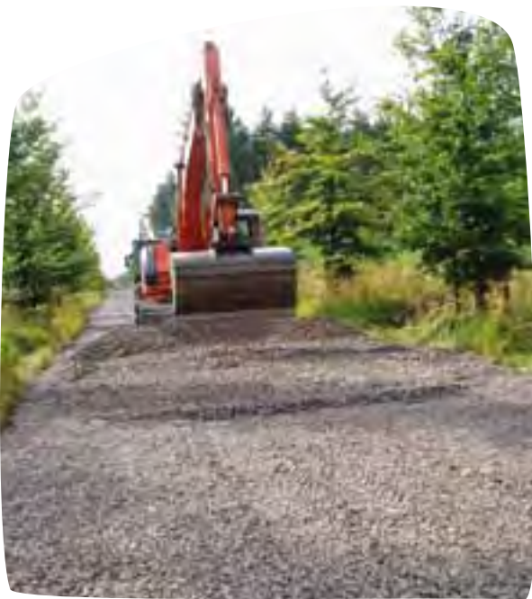
Beeld van de aanlegwerken van een gras-steenslagweg ("Twaalfurendreef" in Kasteelpark Vordenstein, Schoten)
