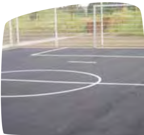
Sportveld uitgevoerd in open asfalt (Parken Ledeborgse Scheldemeander, Gent)
