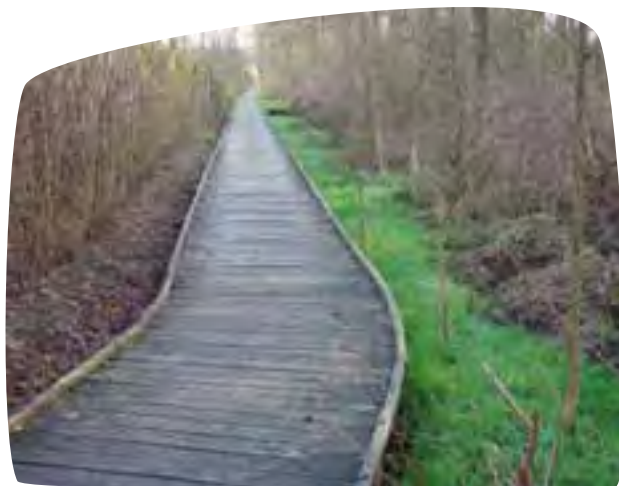
Een vlonderpad waarvan de dekplanken uit hout vervaardigd zijn, inclusief opstaande randen als afboording Foto: Trage Wegen vzw
