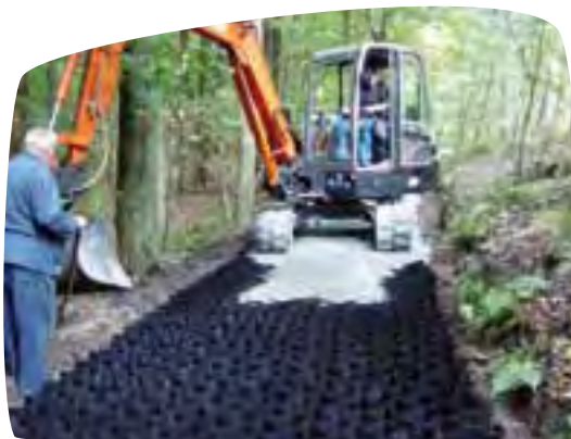
De aanleg van geocellen als versterking van een pad (Zoniënwood, Hoeilaart, Overijse)
