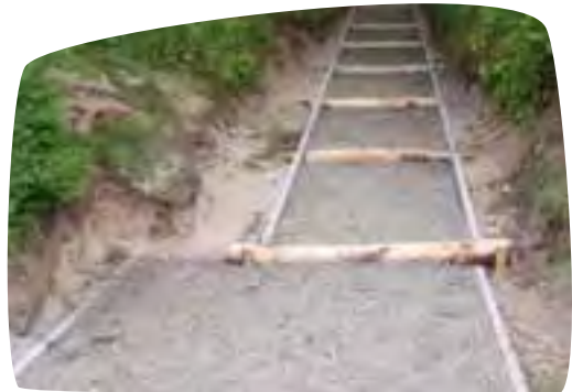
Trap van ontschorst hout en halfverharding (Duinbossen, Klemskerke, De Haan) Foto: ANB
