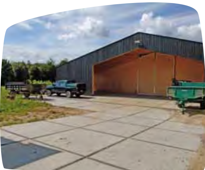
Opslagloods met een aanpalende verharding van betonplaten (Groenendaal, Hoeilaart)
