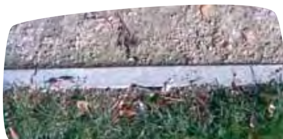
Opsluiting van een halfverharding met een betonelement
