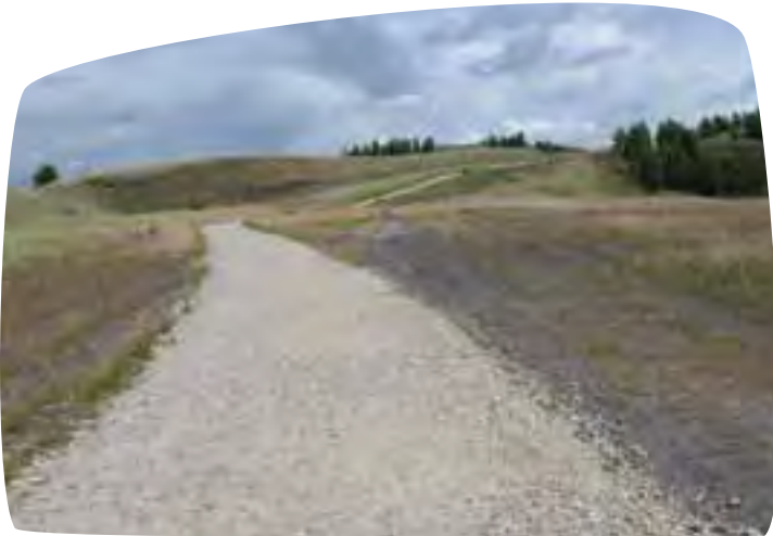
Een recreatief pad uitgevoerd in gebroken betonpuin (Mijnsite, Heusden-Zolder)
