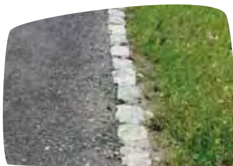
Opsluiting van een halfverharding met een rij kasseien
