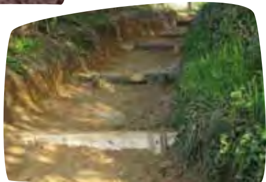
Palen en planken van Tamme kastanje (eigen houtproductie) vastgenageld met kepernagels (Doevevallei, Westouter, Heuvelland) Foto: ANB
