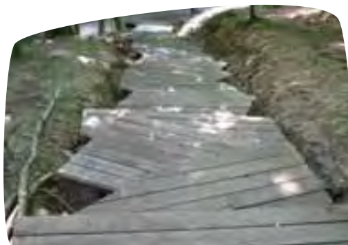
Trap met volhouten draagstructuur en houten planken als loopvlakken (Zoniënwood, Hoeilaart, Overijse) Foto: ANB
