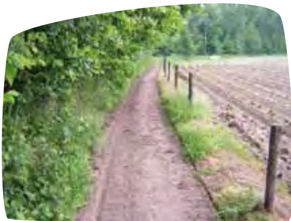
Een grondpad voor recreatief gebruik gelegen naast een landbouwperceel Op regelmatige basis wordt dit mechanisch geëgaliseerd, maar het bodemmateriaal is autochtoon. Foto: Trage Wegen vzw
