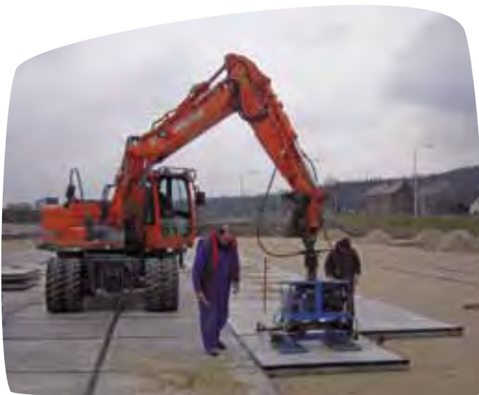
De plaatsing van betonplaten
