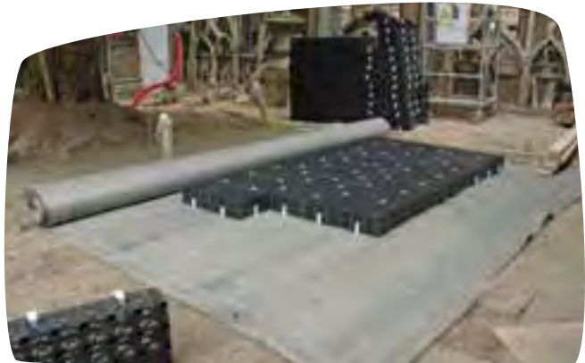
Aanleg van een sandwichconstructie (Sint-Lucas, Gent) Foto: Inverde
