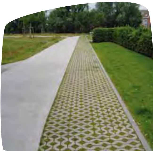
Een tweeledige verharding bestaande uit beton (links) en grasbetontegels (rechts) (Groene Vallei, Gent) Dit beeld toont de situatie kort na de aanleg.
