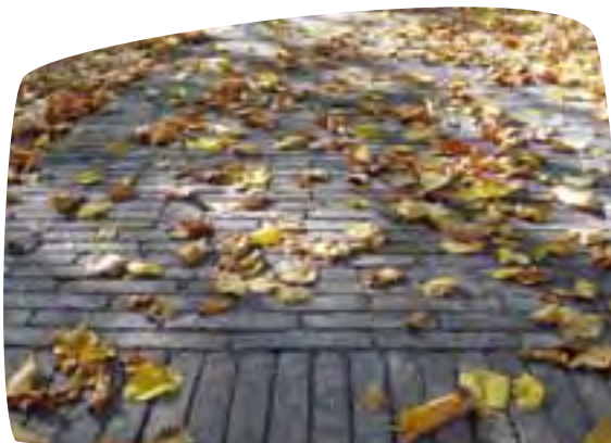
Ophoping van bladeren op een elementenverharding
