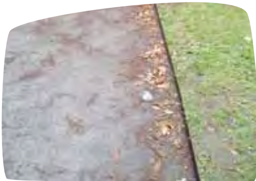
Opsluiting van een halfverharding met een metalen profiel
