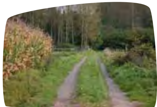
Tweesporenpad in steenslag Foto: Trage Wegen vzw
