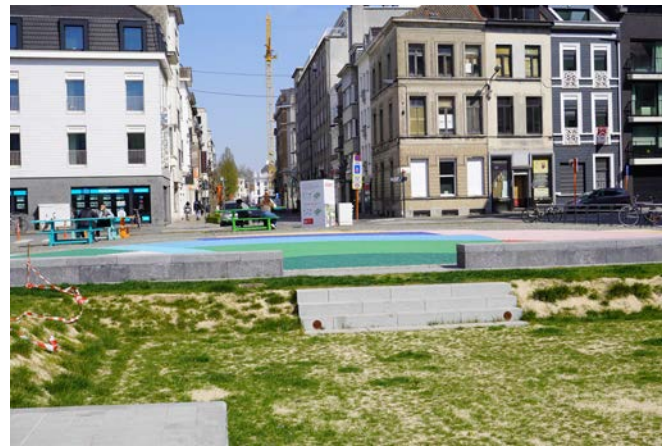
De verlaagde bowlingrin dient als extra bufferruimte en zal bij piekbuien niet betreedbaar zijn.
