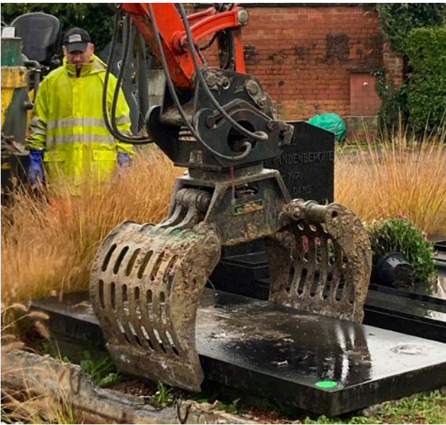
Het verwijderen van de grafzerken moest zorgvuldig gebeuren door de aannemer, zodat deze zo min mogelijk braken. © fallow
