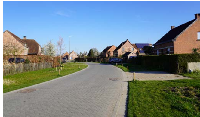
Projecten zoals de heraanleg van de Dijkbaan gebeuren steeds van gevel-tot-gevel. Wadi’s langs weerkanten laten het hemelwater nu infiltreren.
