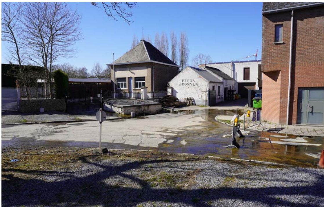
Op het Bronplein komt het kwelwater inmiddels door het asfalt.
