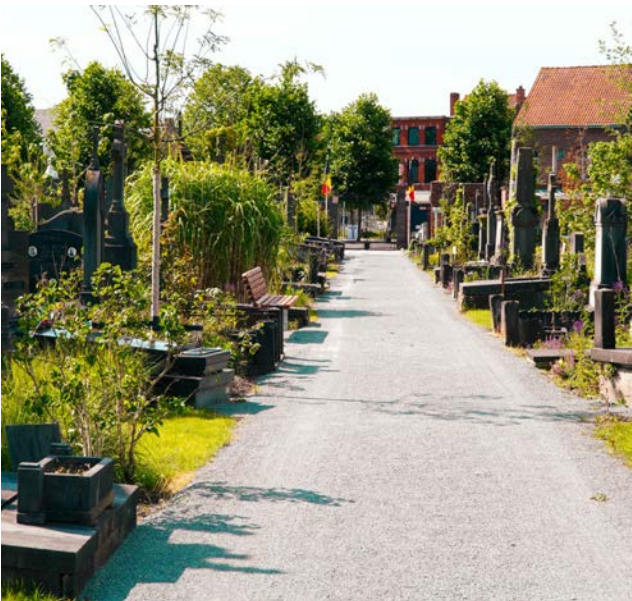
Het hoofdpad aangelegd in porfier is toegankelijk en waterdoorlatend. © fallow
