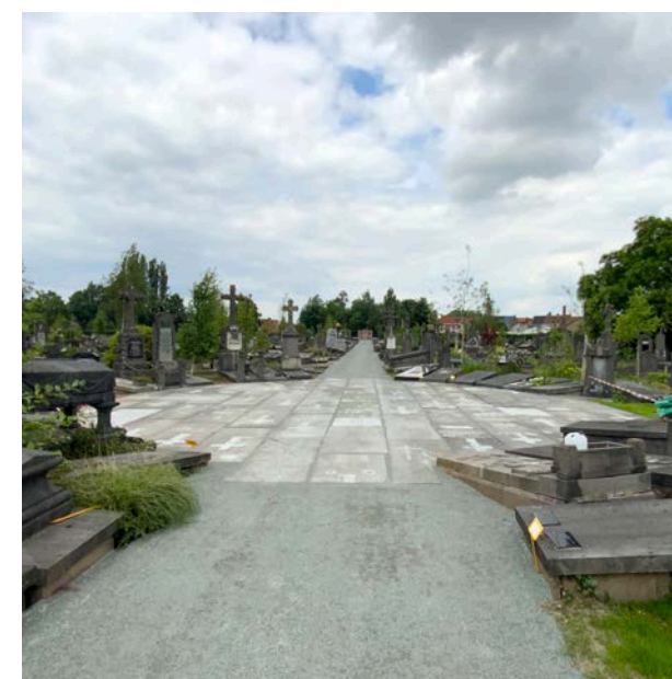
Een deel van de oude grafzerken is hergebruikt voor het aanleggen van het hoofdpad van het begraafpark. © fallow
