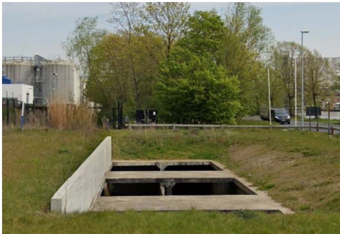
De Mandel stroomt aan westelijke zijde van de brug richting Roeselare door een open koker. © Izegem
