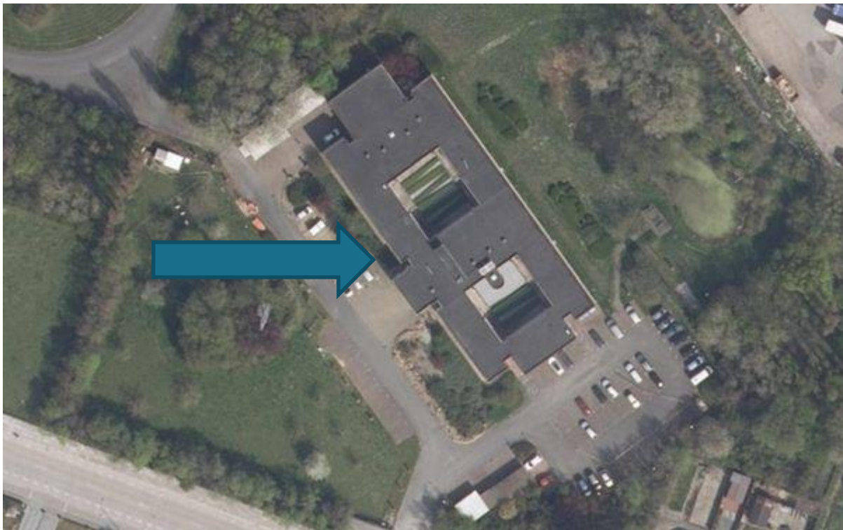
Figuur 12: VMM-gebouw Oostende (administratie)
