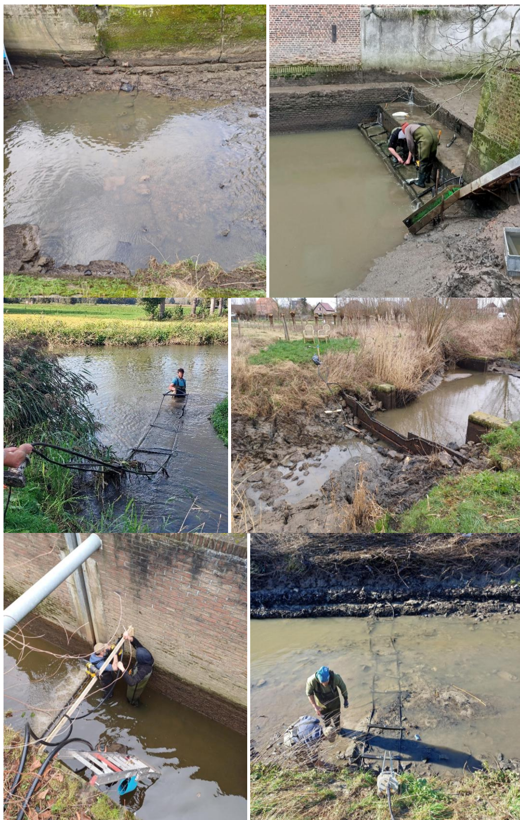
Figuur 13 Foto's van het plaatsen van de antennes: aan de brug
