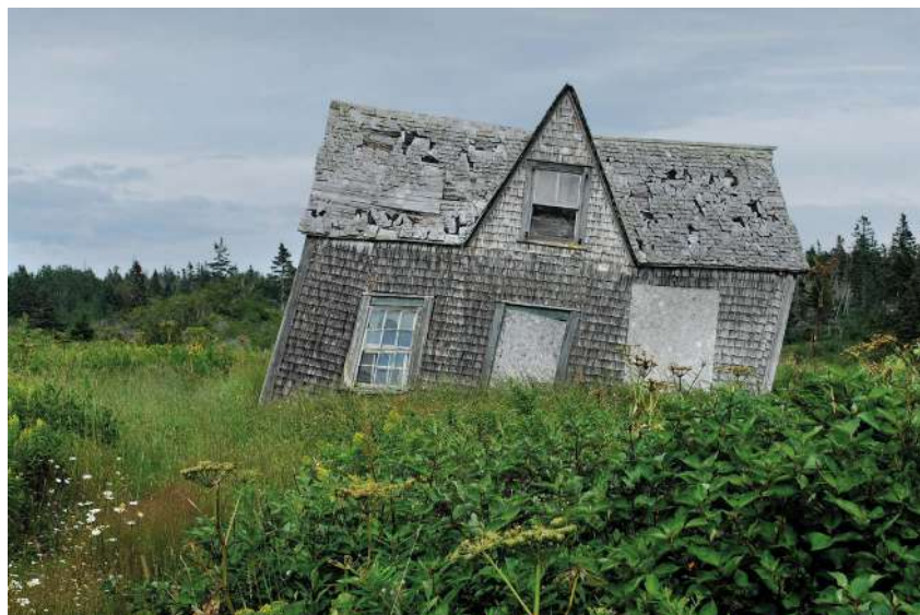
Fig. S59-S60: Constructies gebouwd op een bodem rijk aan zwellende kleien moeten voorzien worden van speciale funderingen, zoniet kunnen ze grote schade ondervinden. Dit is een belangrijke post bij verzekeringsmaatschappijen voor schadevergoedingen. S59: © https://buildfree.org/foundation-repairs.html , S60: © https://getinthering.co/land-subsidence .
