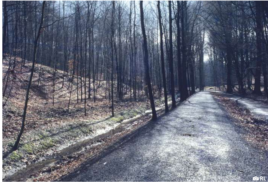
Fig. E9: Voorbeeld van een verharde weg. Wegen concentreren en draineren heel veel water dat afvloeit naar de depressies en waar het erosie veroorzaakt. (Blankedelleweg, Zoniënwood, Oudergem, Brussels Hoofdstedelijk Gewest, België).
