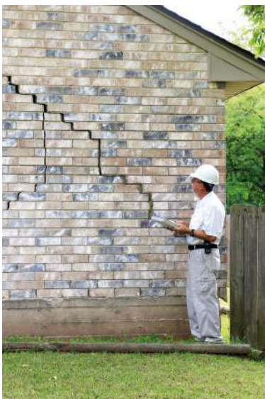
Fig. S59-S60: Constructies gebouwd op een bodem rijk aan zwellende kleien moeten voorzien worden van speciale funderingen, zoniet kunnen ze grote schade ondervinden. Dit is een belangrijke post bij verzekeringsmaatschappijen voor schadevergoedingen. S59: © https://buildfree.org/foundation-repairs.html , S60: © https://getinthering.co/land-subsidence .
