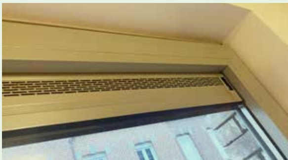
/ Voorbeeld van een manueel regelbare toevoeropening
