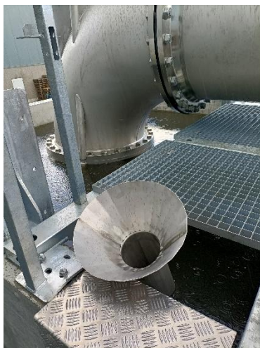
Foto 3: Trechter voor invoer van de vissen in de pompkelder
