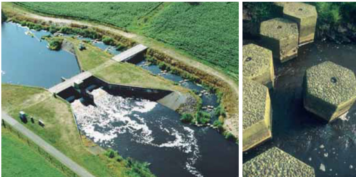
Figuur 11 – Voorbeeld op de Regge te Overwater (NL) van een vertical slot-vispassage geïntegreerd in een nevengeul. Links: overzicht ligging (Foto: Waterschap Regge en Dinkel) Rechts: Detailopname van een slot (Foto: OVB). Overgenomen uit AMINAL (2005)
