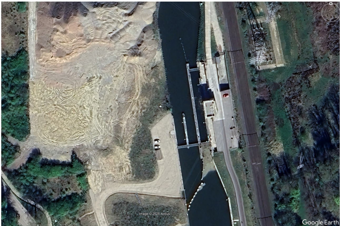
Figuur 4 – Luchtfoto nieuw aangelegde stuwen en sluis de Aalst
