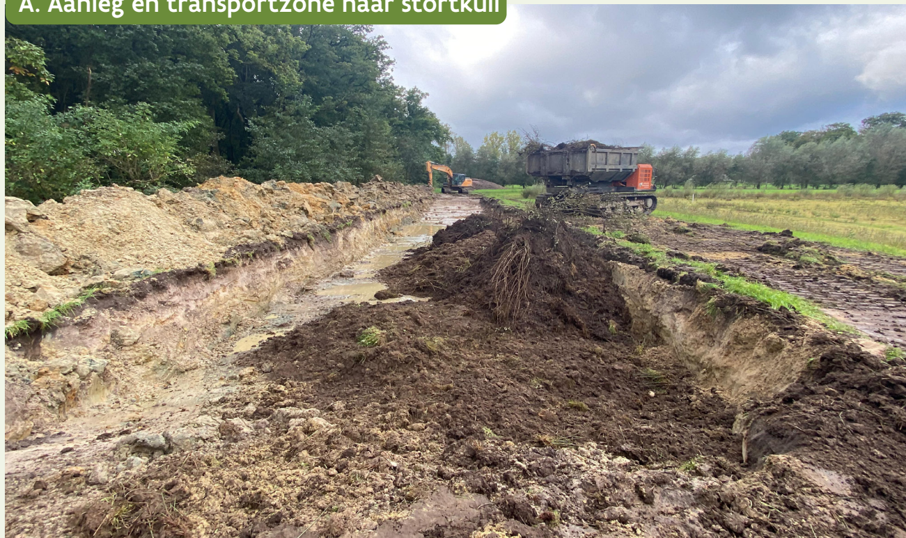
Aanleg stortkuil als sleuf (najaar 2024)
